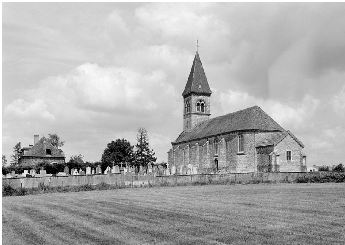
Vue d'ensemble : chevet et élévation droite.
