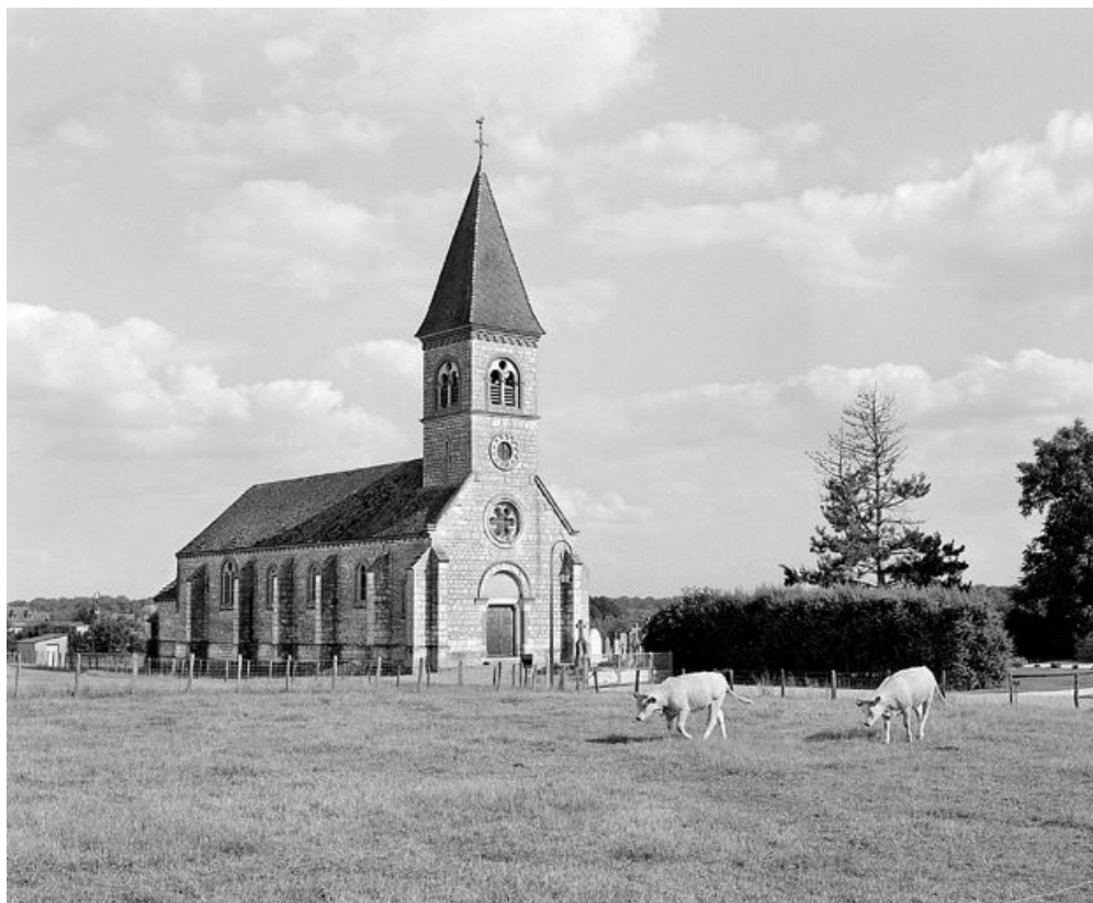
Vue d'ensemble : façade et élévation gauche.
