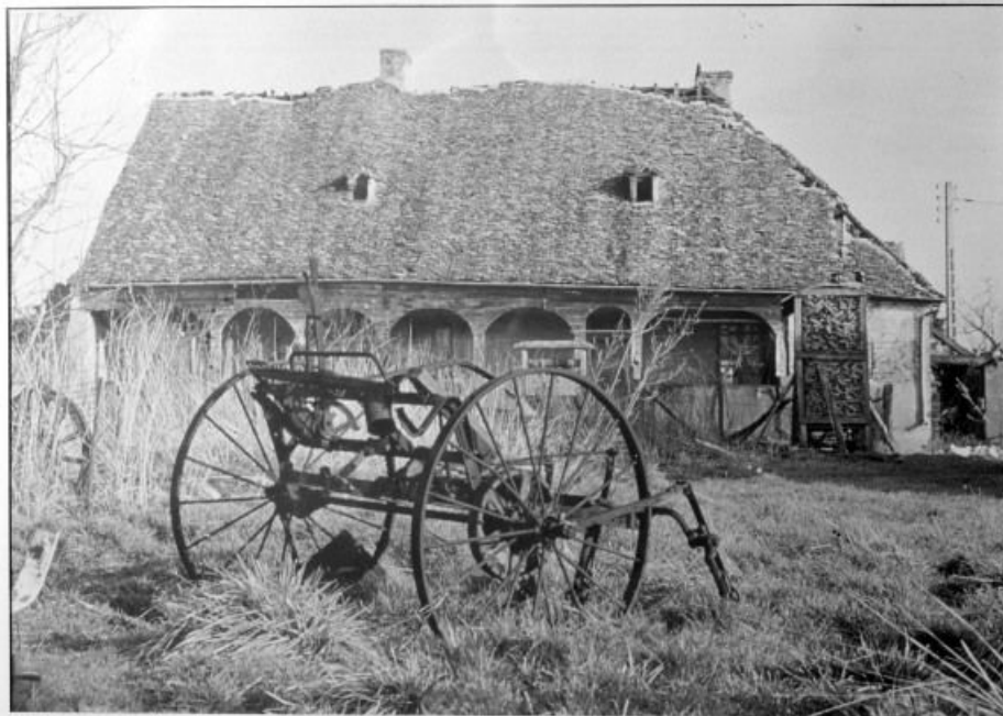
Vue d'ensemble. Photographie ancienne.
