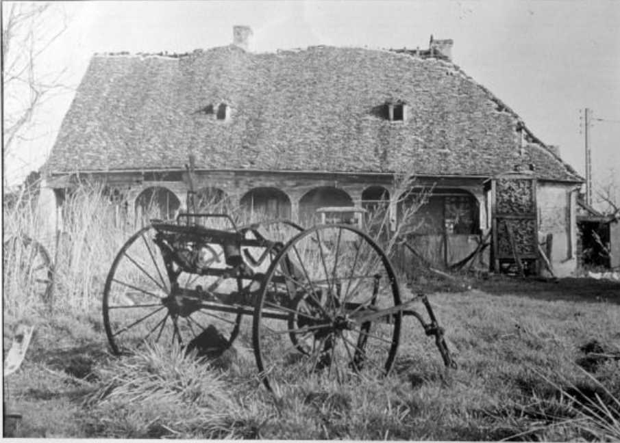
Vue d'ensemble. Photographie ancienne.
