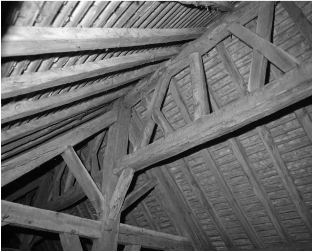
Charpente de la nef, détail du contreventement.
