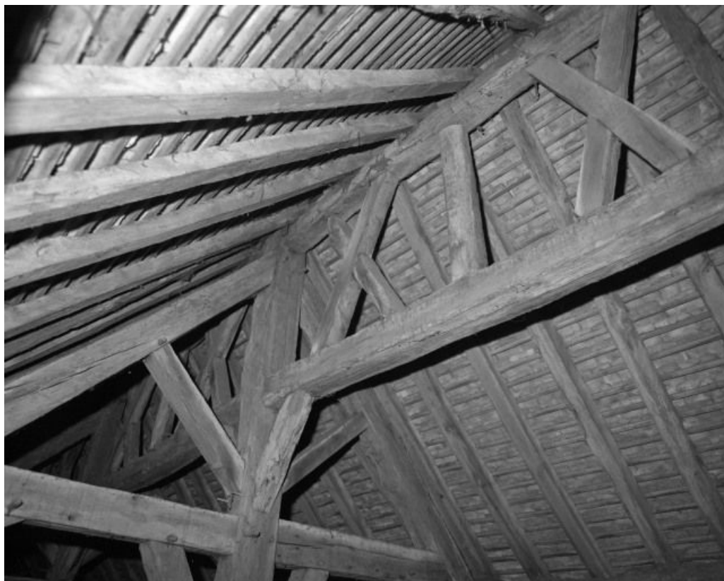
Charpente de la nef, détail du contreventement.
