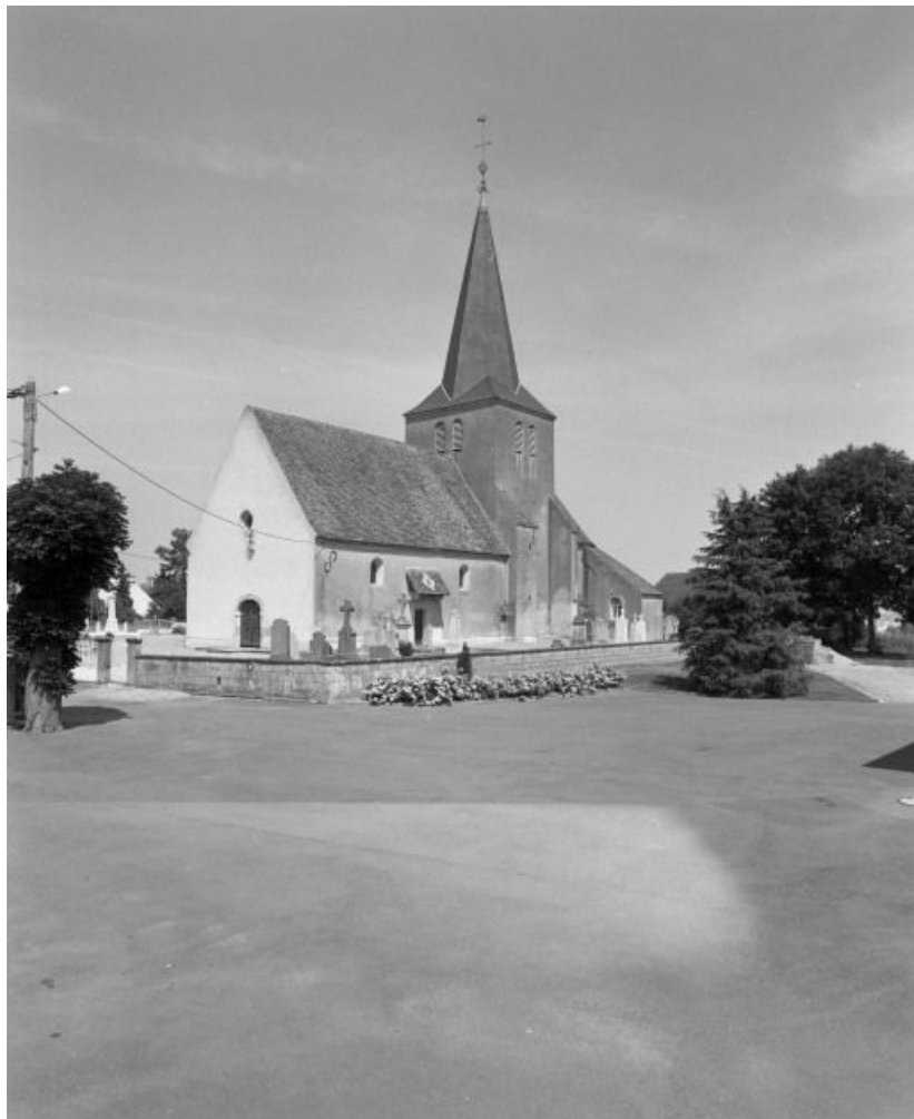
Vue d'ensemble : façade et élévation droite.
