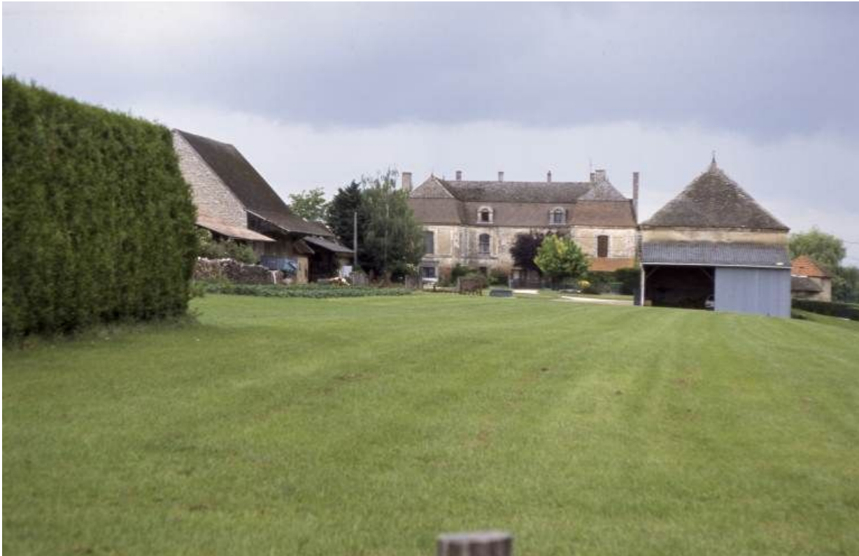
Vue d'ensemble, façade du logis.
