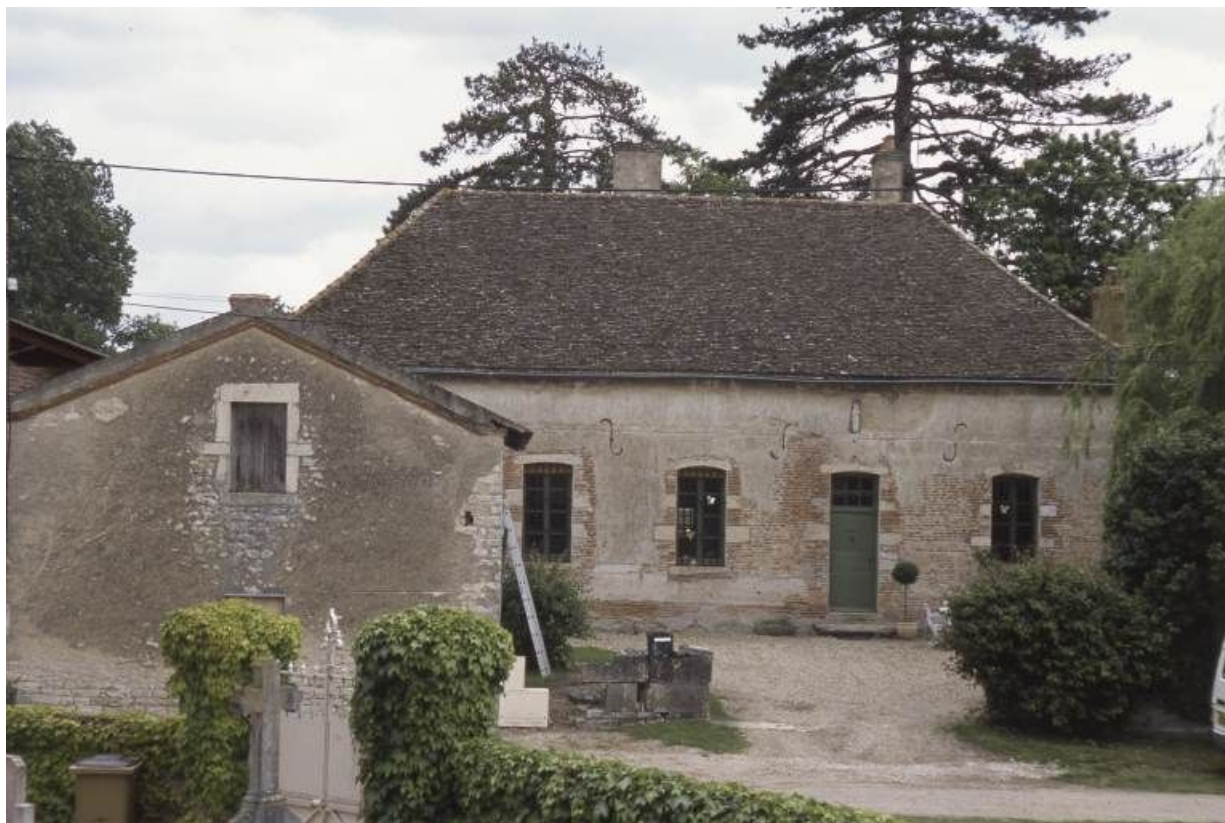
Vue d'ensemble. 71, Pontoux Eglise
