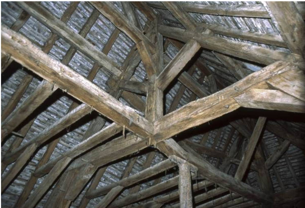
Logis secondaire, partie supérieure de la charpente.
