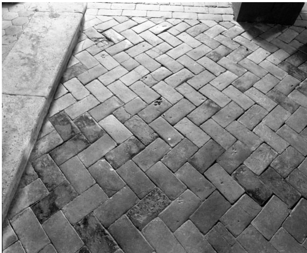
Détail du carrelage en terre cuite.
