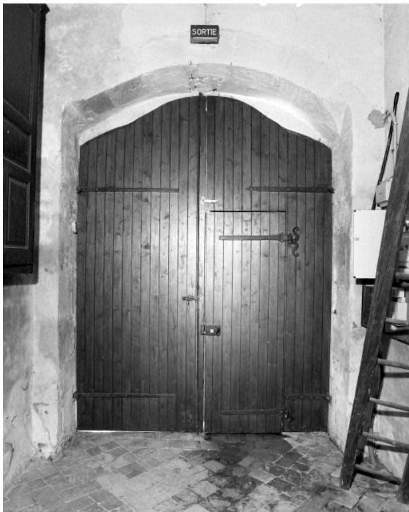
Porche : porte de le nef 71, Pontoux Eglise
