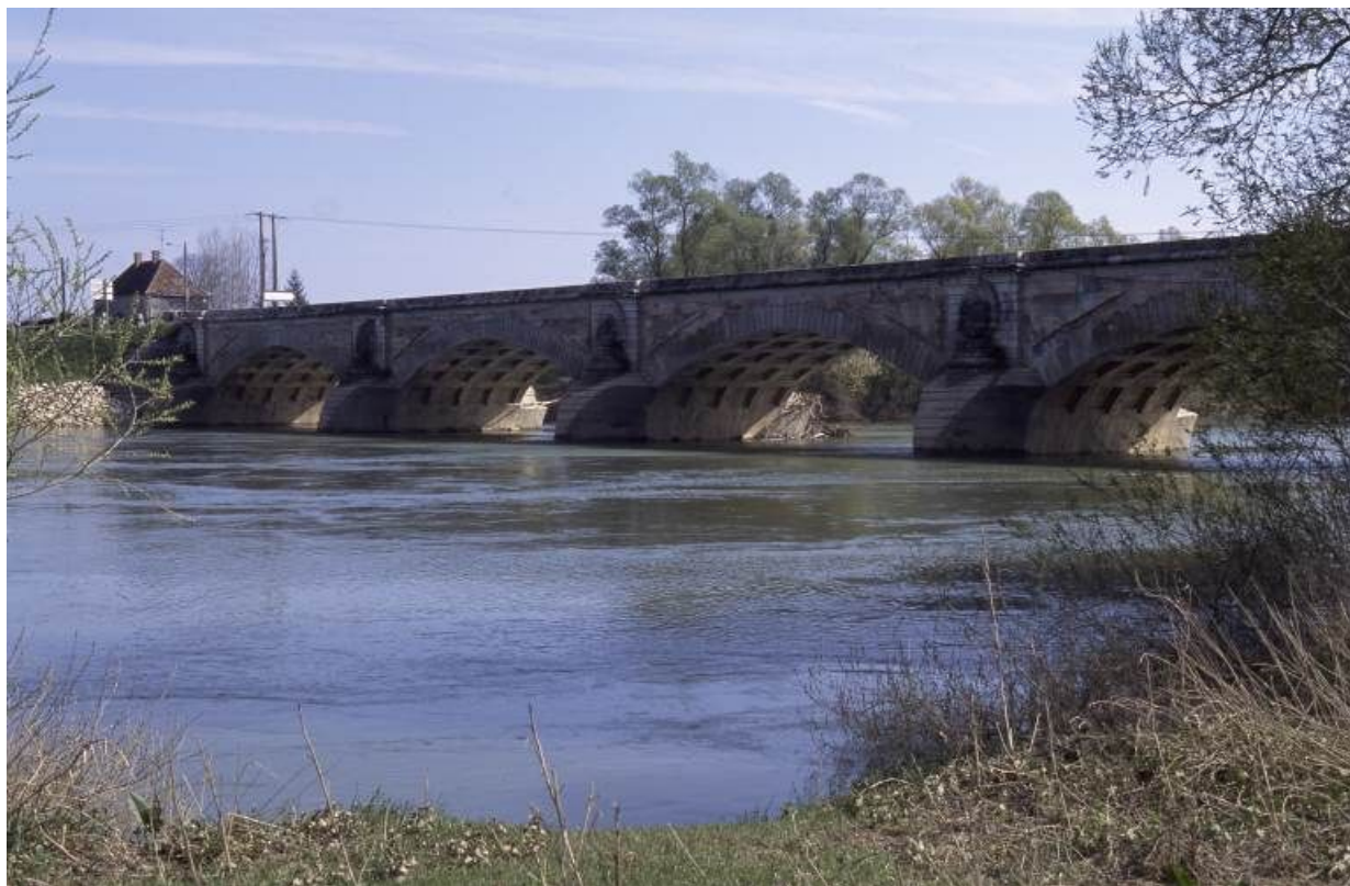
Vue d'ensemble de trois-quarts droit, en aval.
