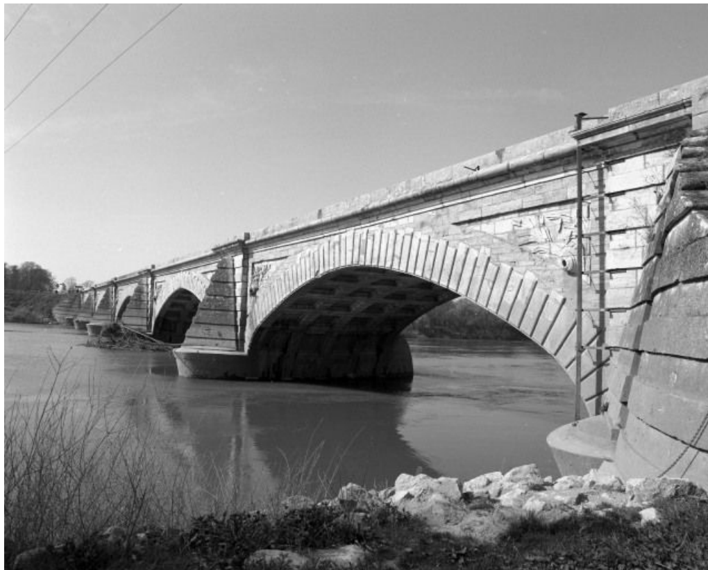
Vue d'ensemble rapprochée, en amont. 71, Navilly R.N. 73
