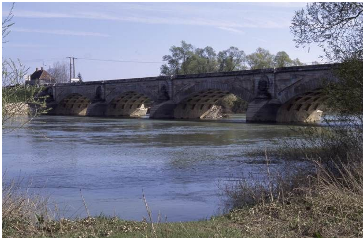
Vue d'ensemble de trois-quarts droit, en aval.
