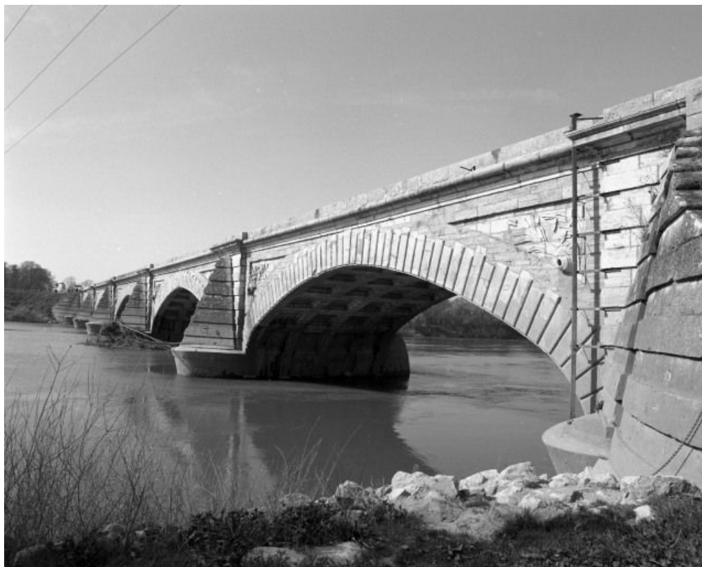
Vue d'ensemble rapprochée, en amont. 71, Navilly R.N. 73
