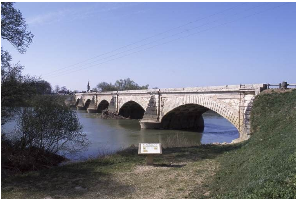
Vue d'ensemble en amont.
