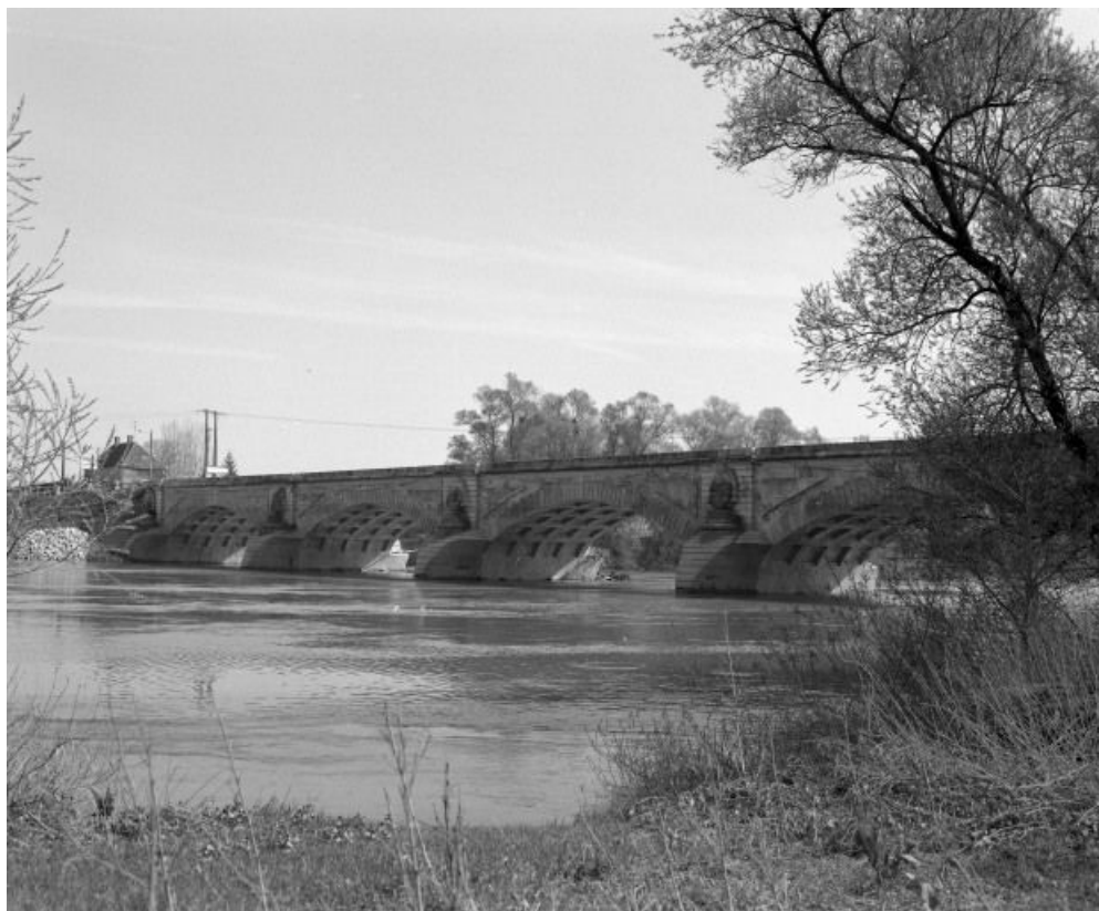
Vue d'ensemble de trois-quarts droit, en aval.
