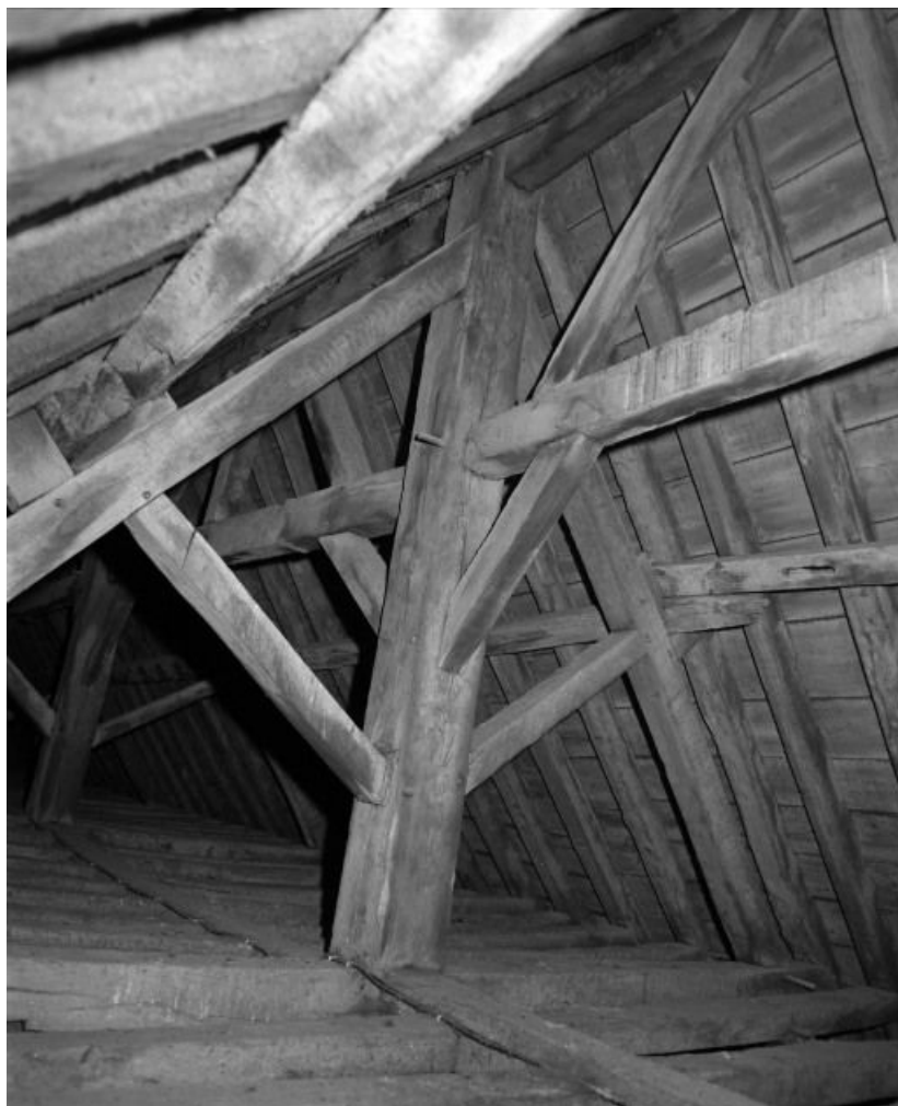
Comble : charpente de la nef.
