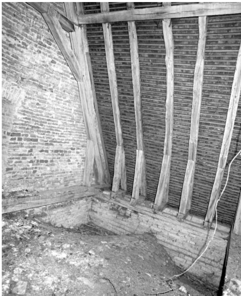
Comble du chœur, angle avec le mur de la nef.
