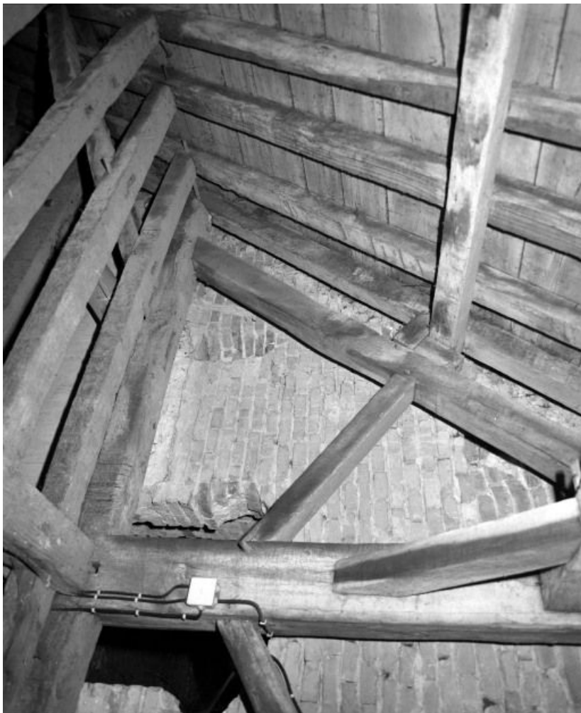
Comble : mur avec petite niche entre la nef et le chœur.
