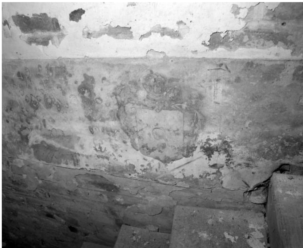
Porche : litre funéraire sur le mur de la nef dans la cage de l'escalier du comble. 71, Longepierre Bourg
