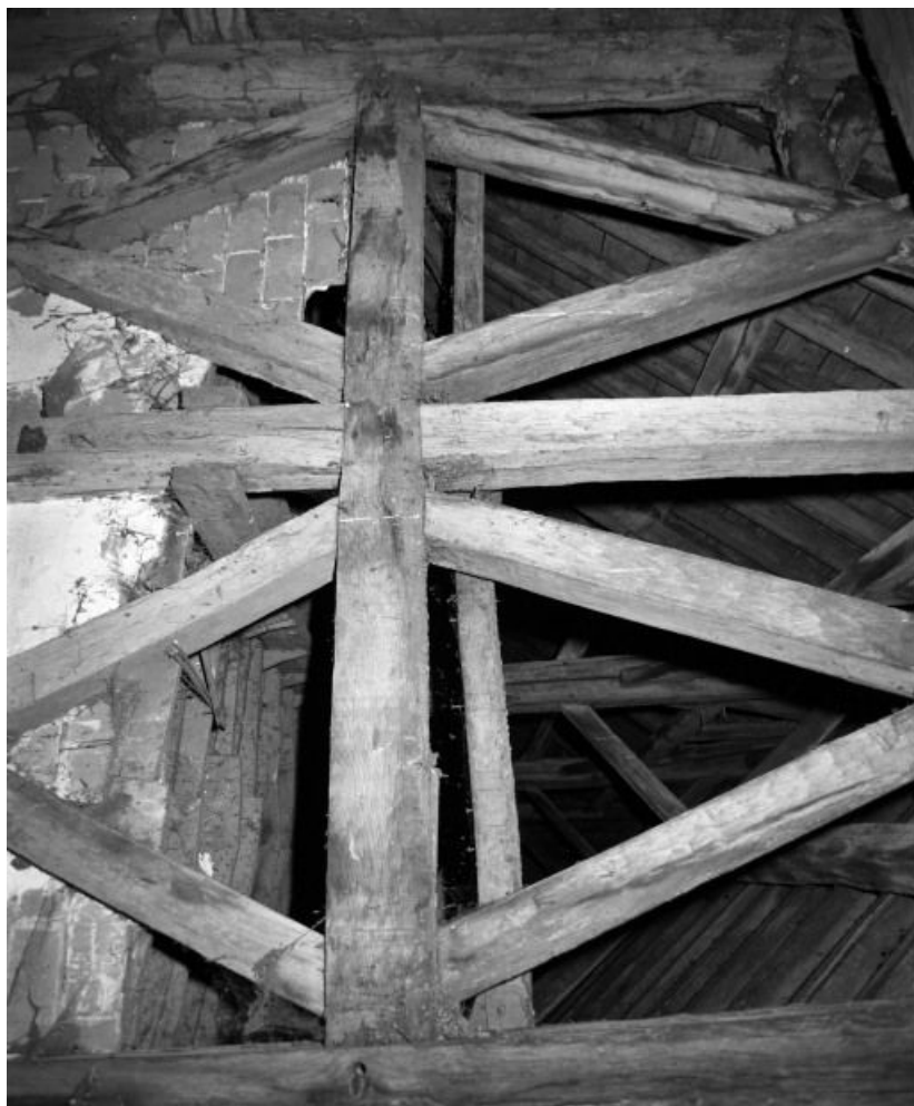
Comble : charpente du beffroi, côté nef.
