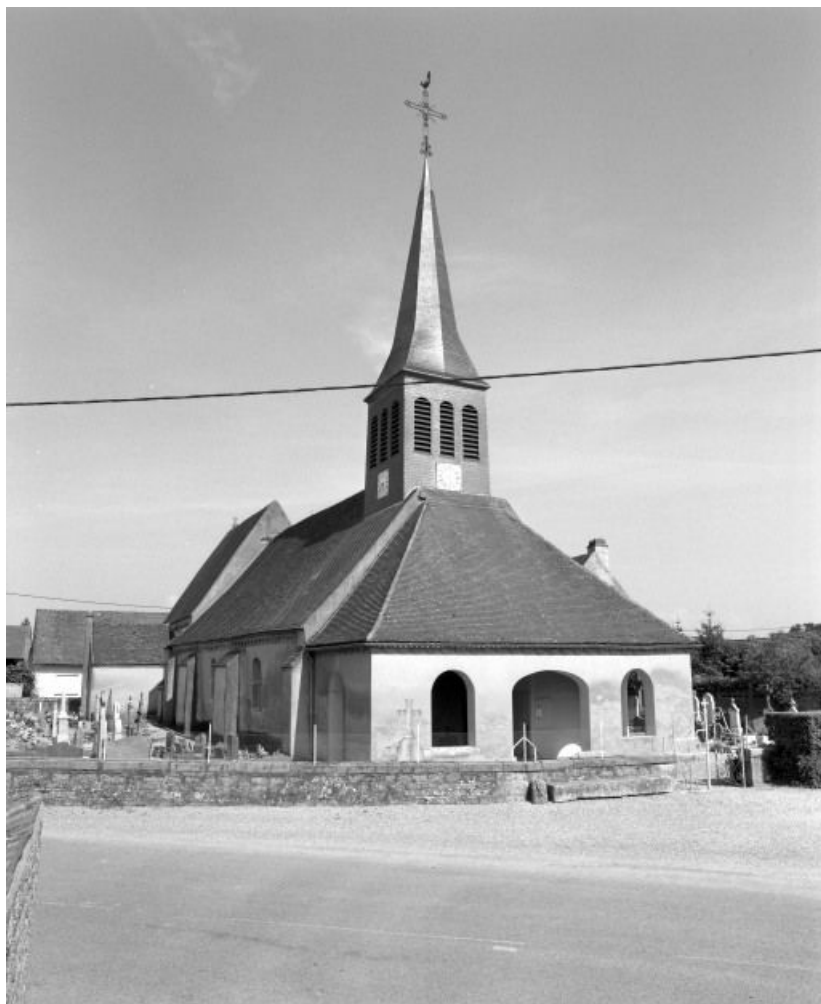
Vue d'ensemble : façade et élévation gauche.
