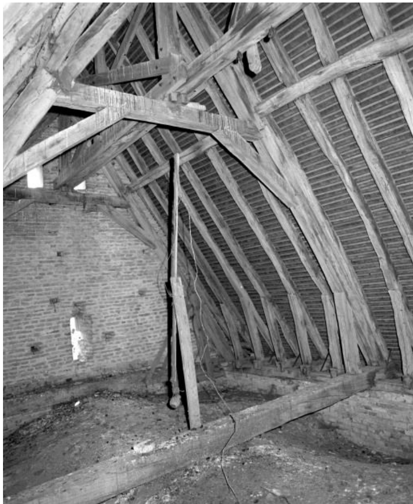
Comble du choeur depuis le mur de la nef. 71, Longepierre Bourg
