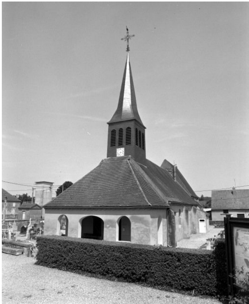
Vue d'ensemble : façade et élévation droite.
