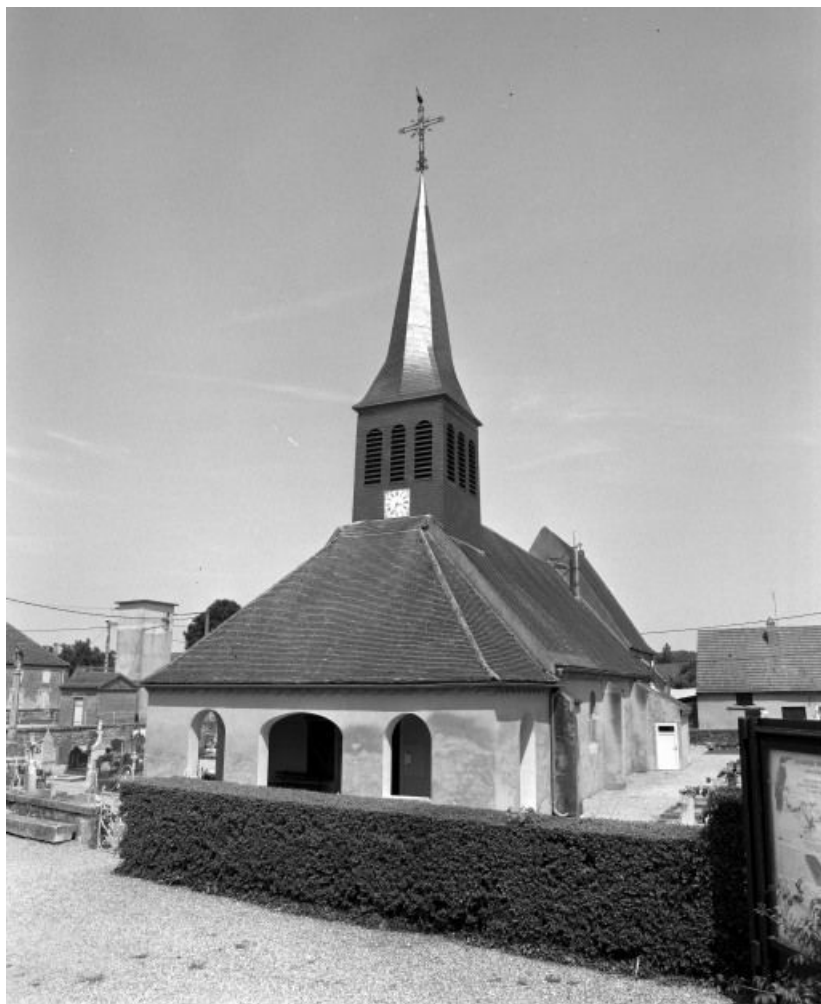
Vue d'ensemble : façade et élévation droite.
