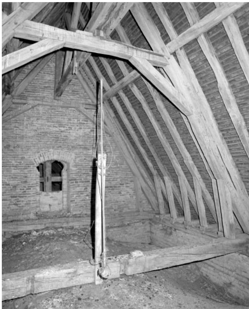
Comble du choeur depuis le mur du chevet.
