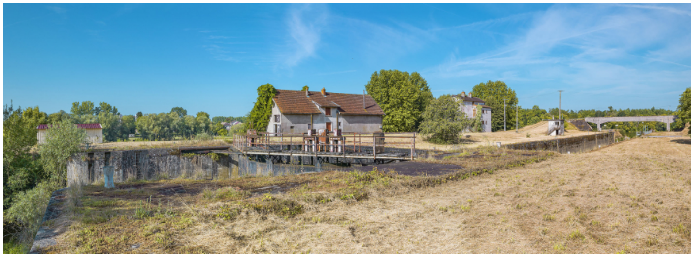
Vue d'ensemble du site d'écluse depuis l'amont. Au fond, la passerelle.
