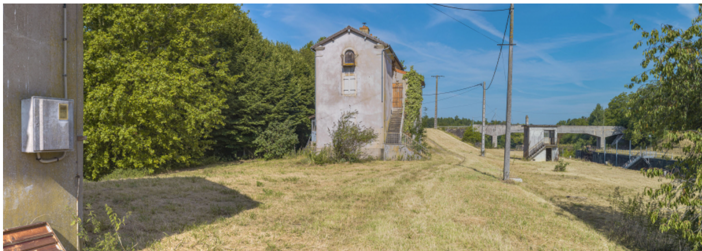
L'ancienne écluse avec au premier plan la maison éclusière et le poste de commande.
