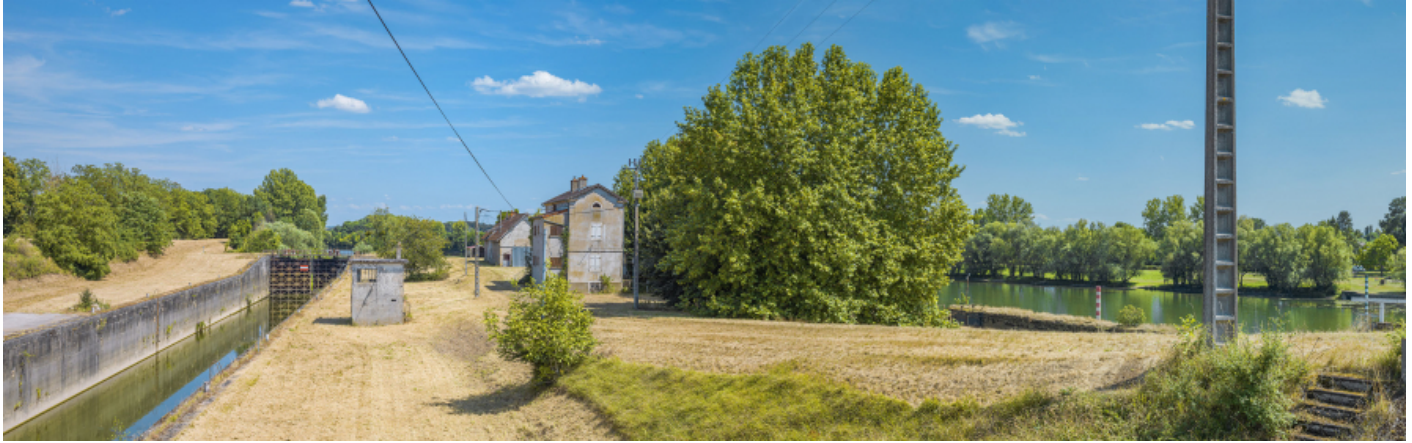
Vue d'ensemble du site d'écluse depuis l'aval. 71, Bragny-sur-Saône, lieudit : près du Rompereau
