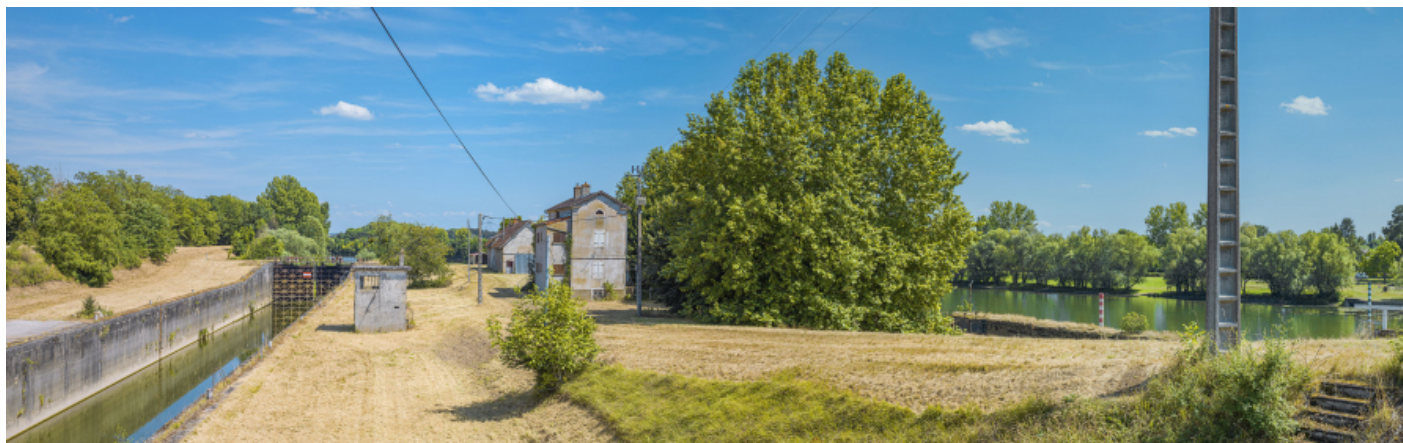
Vue d'ensemble du site d'écluse depuis l'aval. 71, Bragny-sur-Saône, lieudit : près du Rompereau
