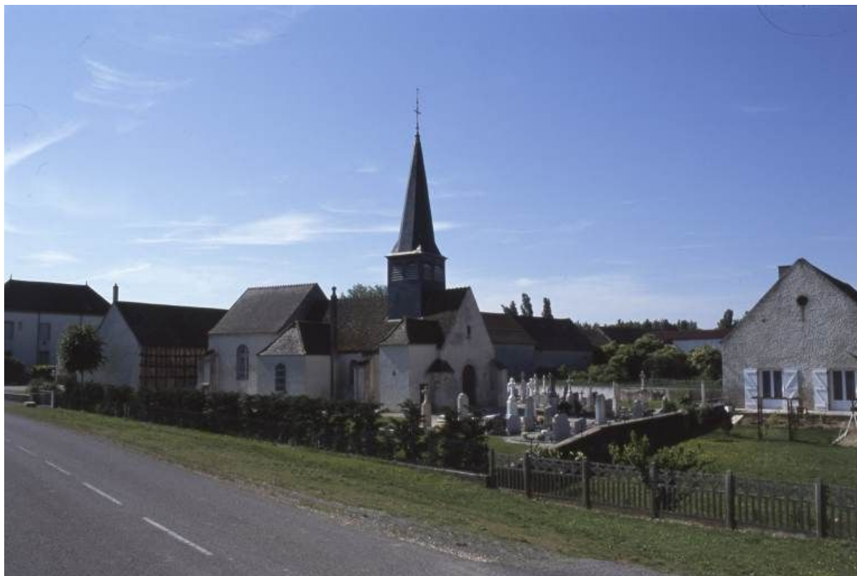
Élévation gauche et façade.
