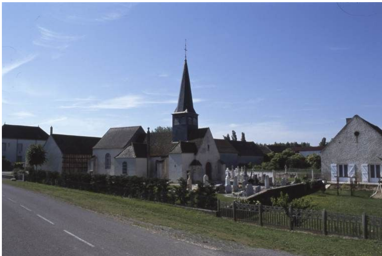
Élévation gauche et façade.
