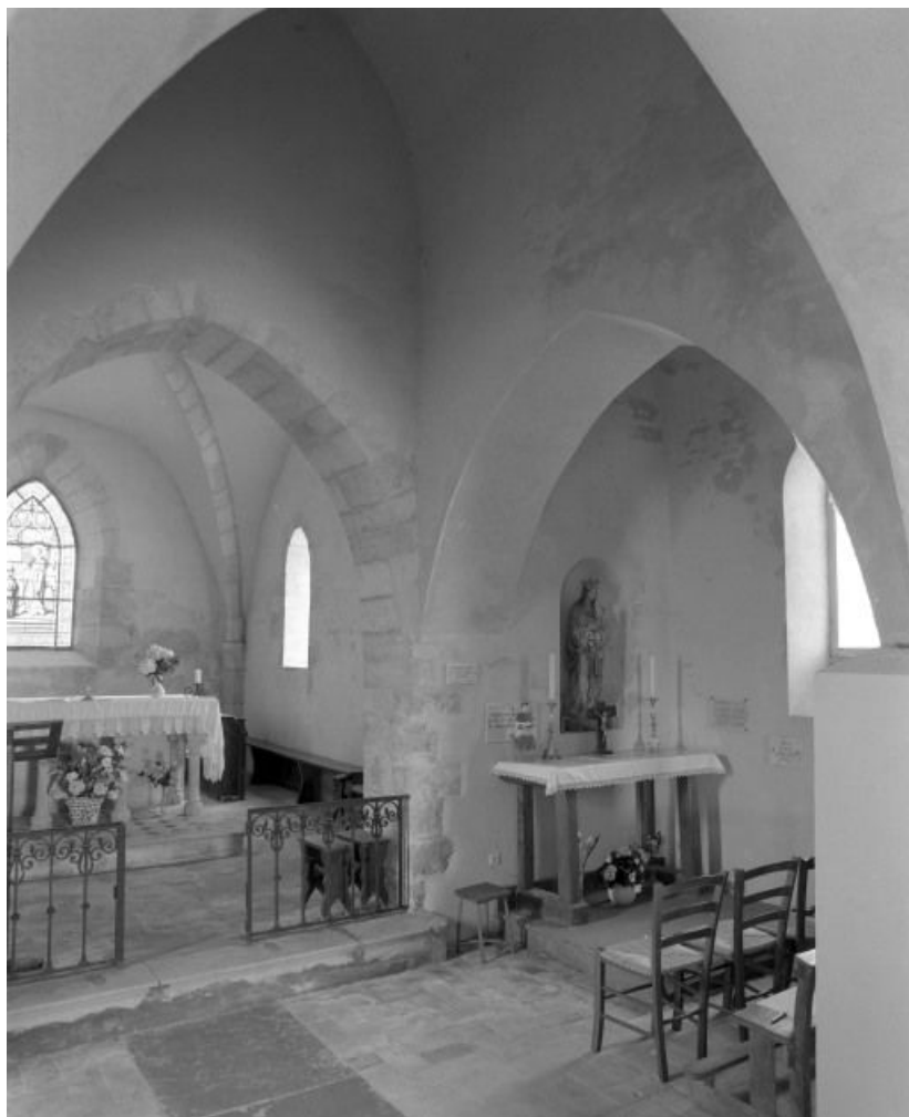
Choeur, travée sous clocher et chapelle droite.
