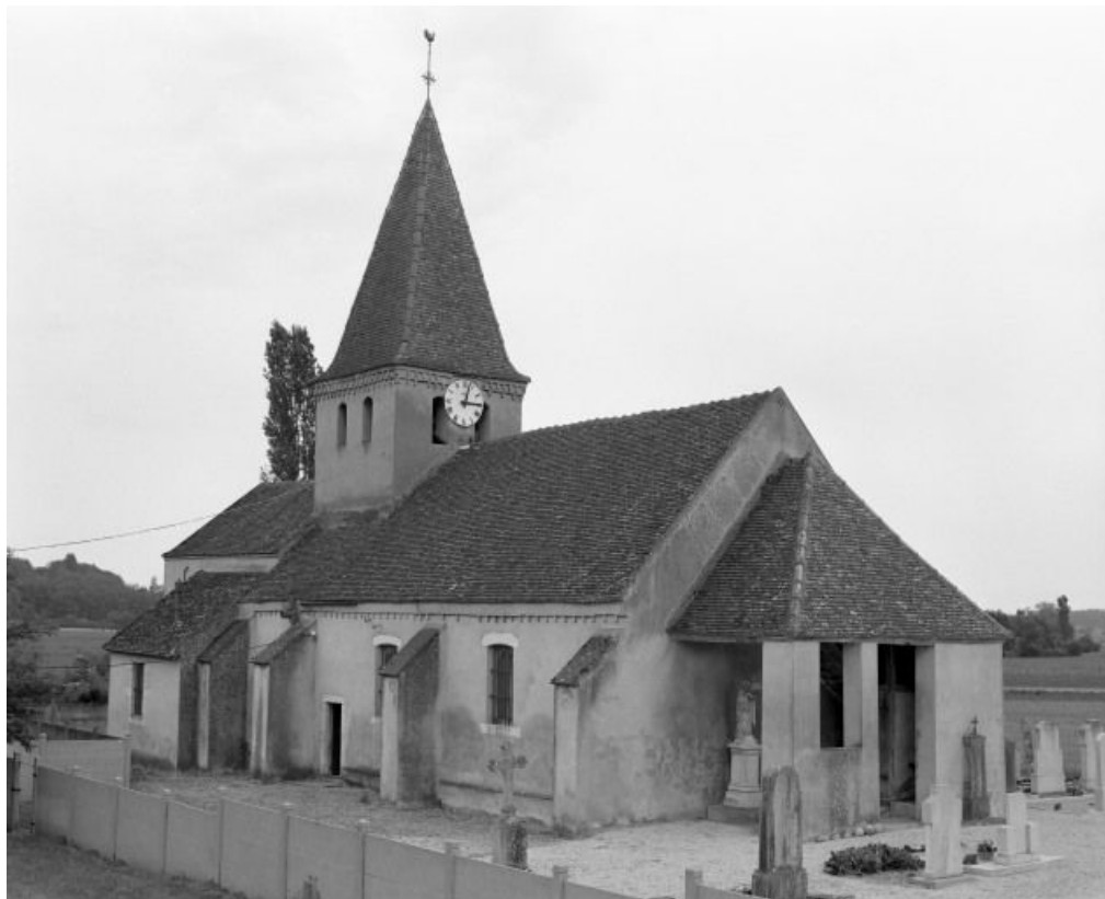
Vue d'ensemble : porche antérieur et élévation gauche.
