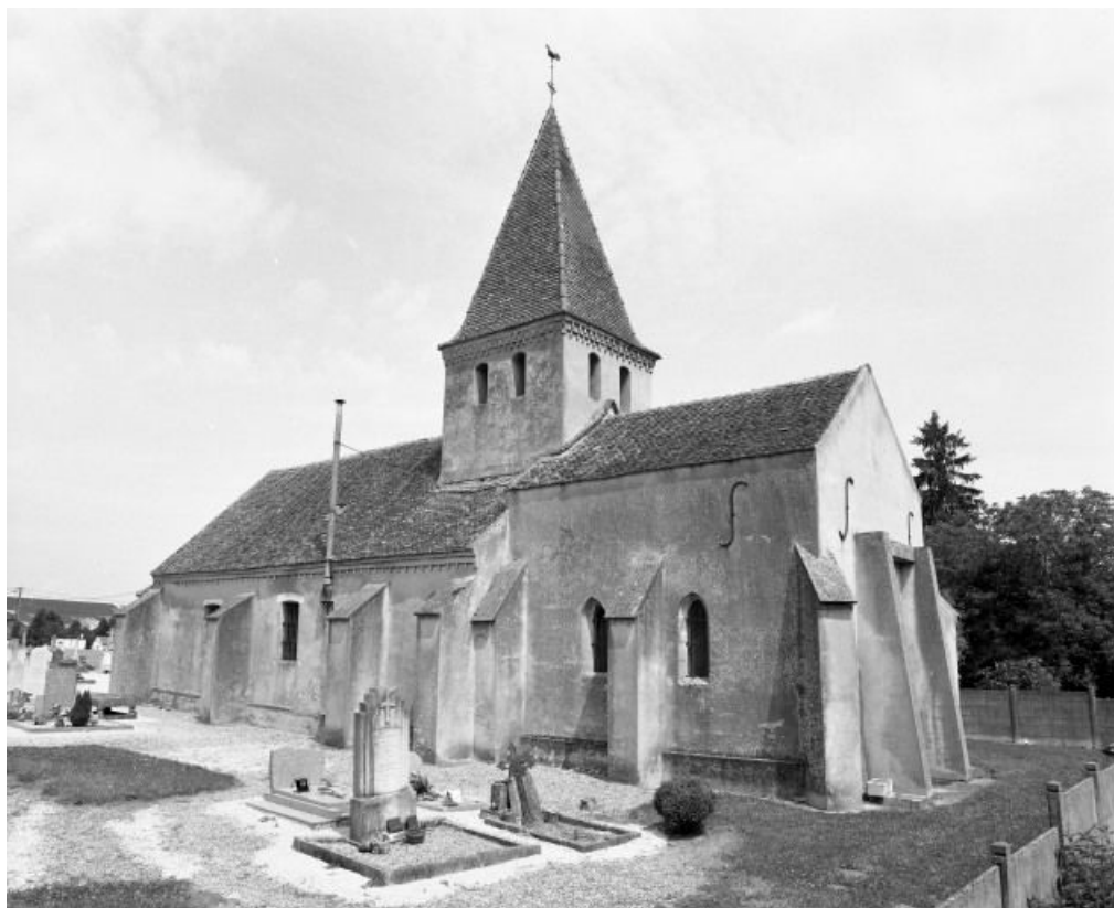
Vue d'ensemble : élévation droite et chevet.
