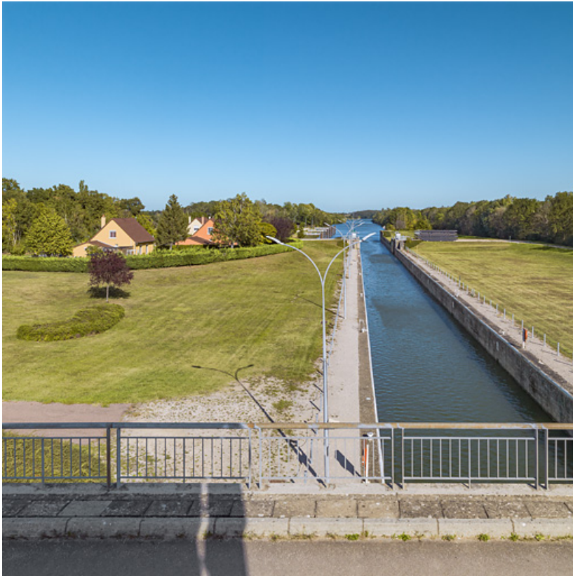
Le sas et le lotissement des employés de VNF, vus depuis le pont sur écluse.
