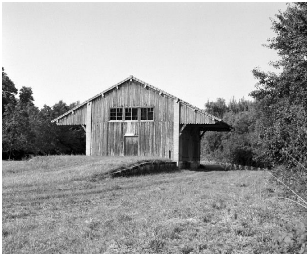
Gare de marchandises, pignon en bois.
