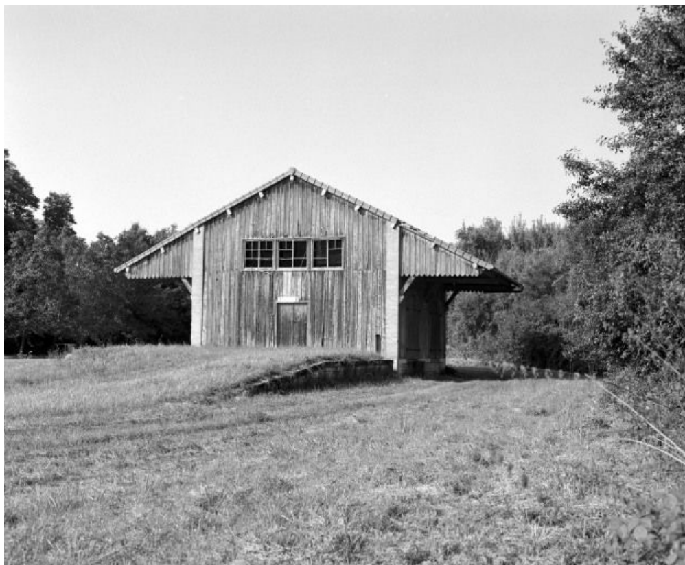
Gare de marchandises, pignon en bois.
