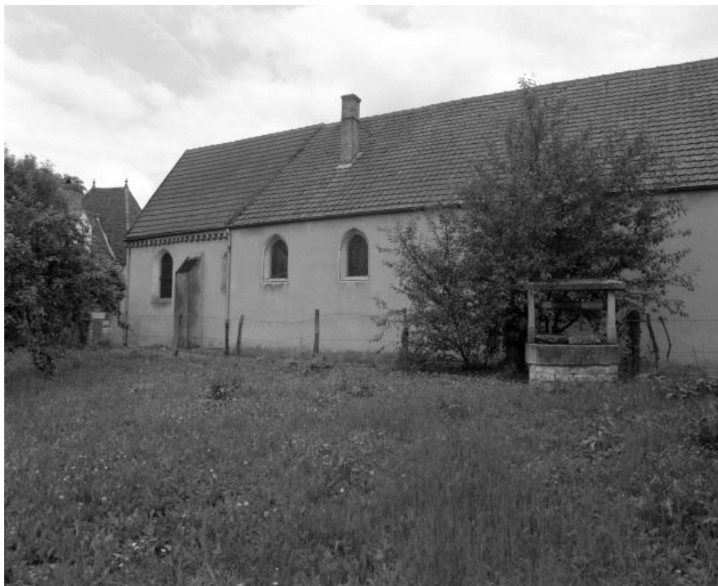
Élévation gauche du choeur et de la nef.
