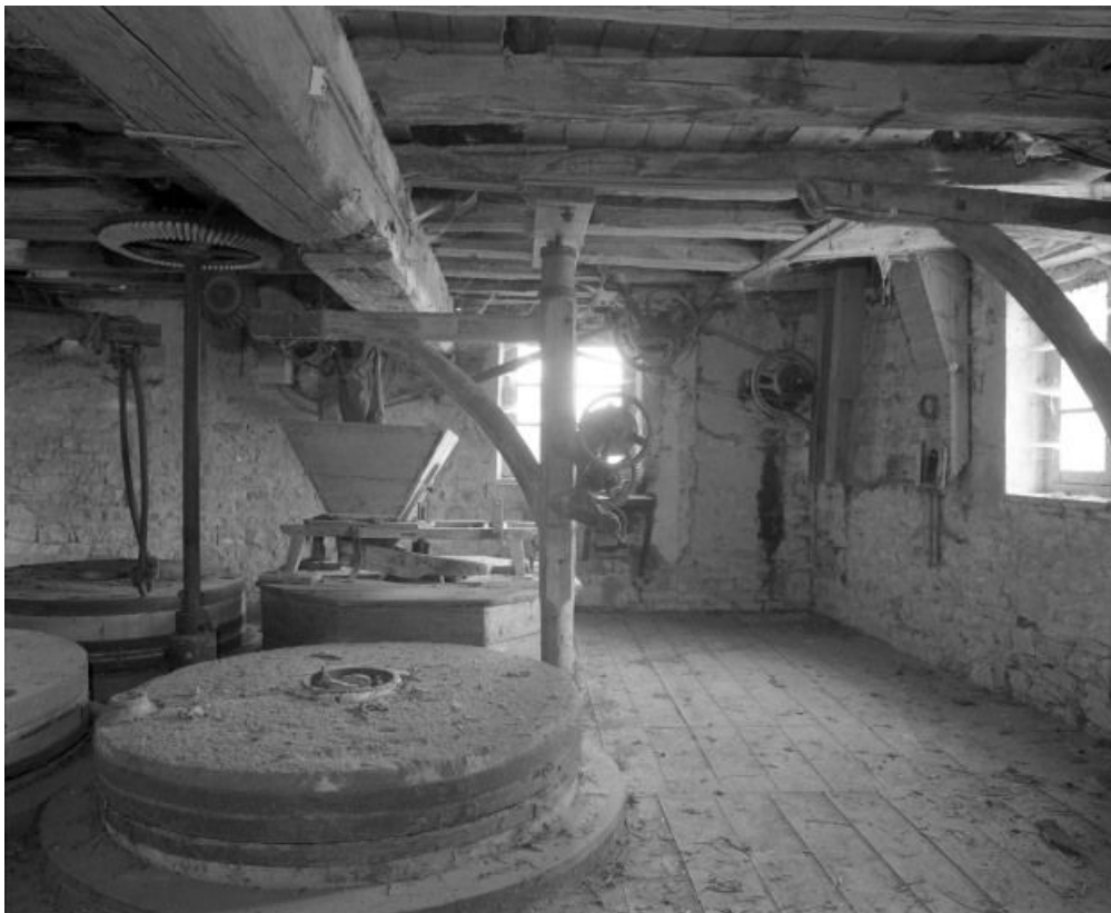
Bâtiment est : niveau supérieur, vue prise du sud.
