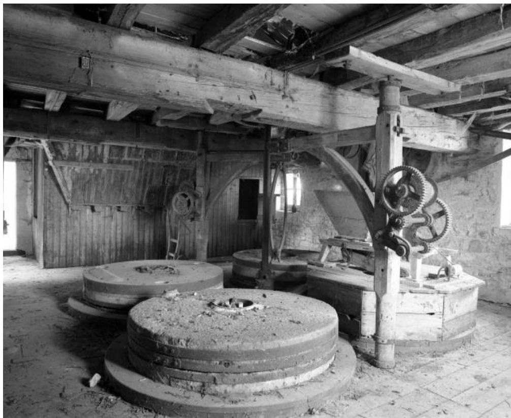
Bâtiment est : niveau supérieur, vue prise de l'angle sud-est.
