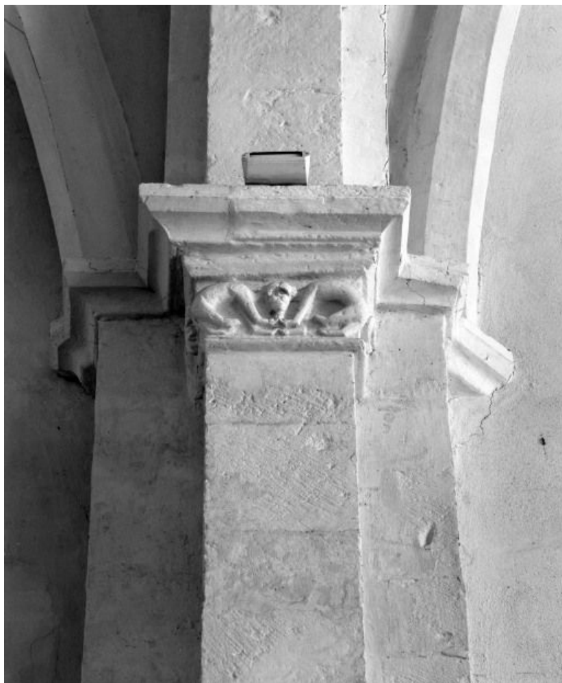
Nef, vaisseau central, chapiteau droit du 1er arc doubleau.
