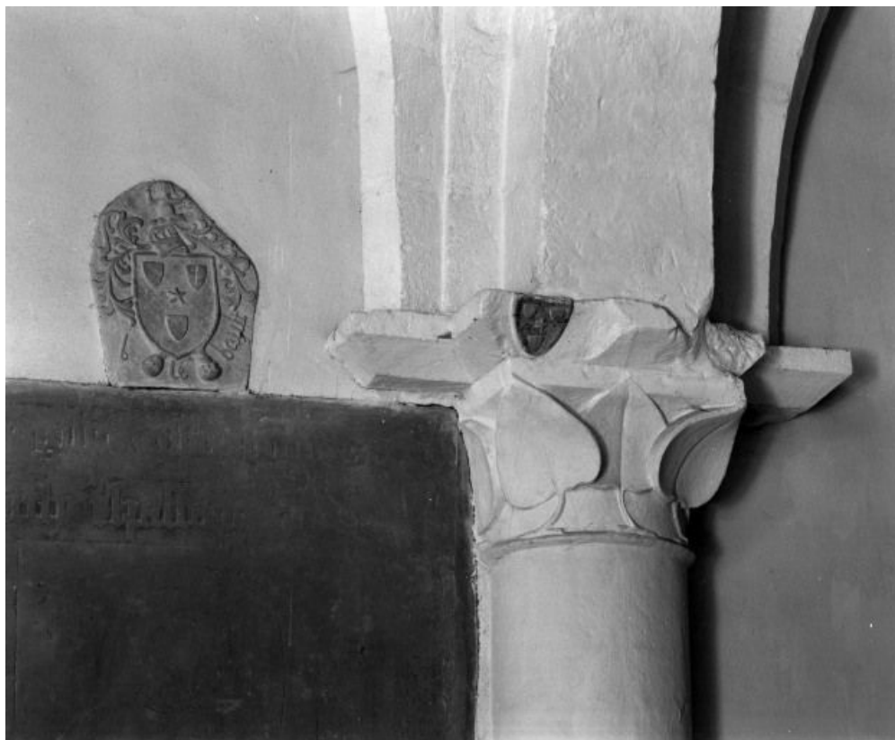
Bas-côté gauche (nord), 1ère travée, chapiteau gauche de l'arc doubleau. 71, Gergy Eglise
