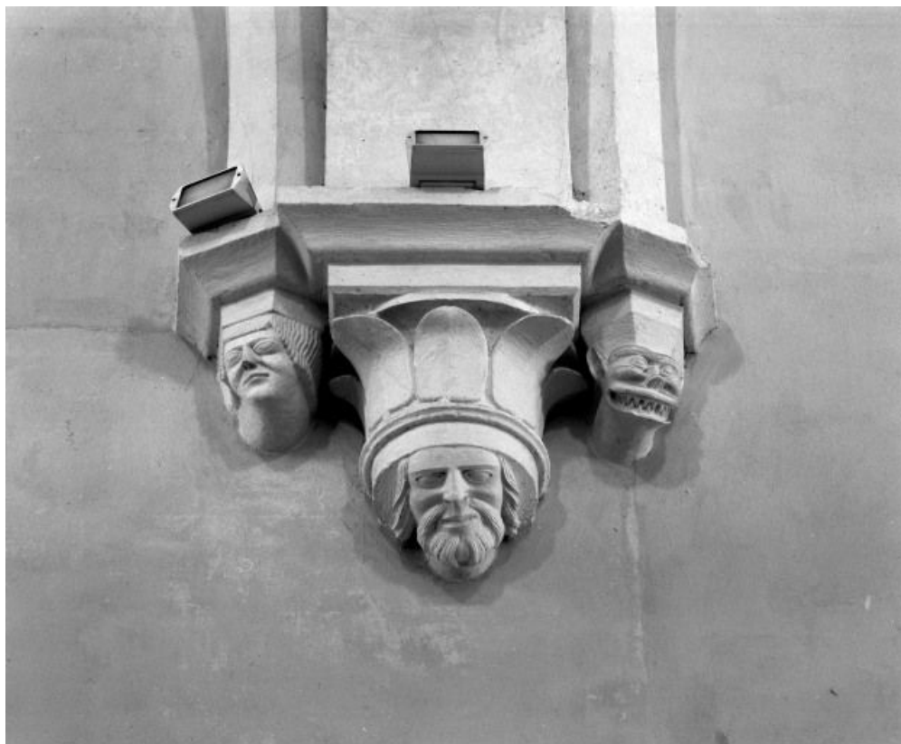
Avant-choeur, mur droit : culots situés entre les 2 travées.
