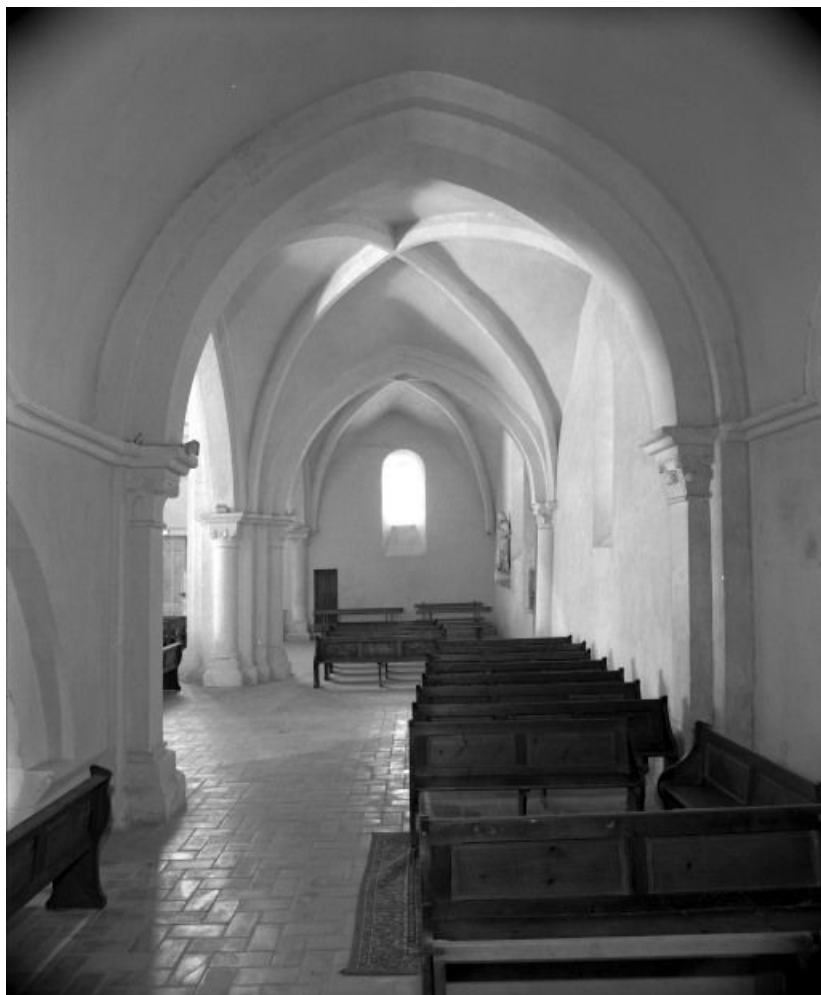
Bas-côté gauche (nord), vue prise de la chapelle.
