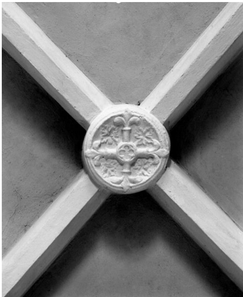
Nef, clef de voûte de la 2e travée.
