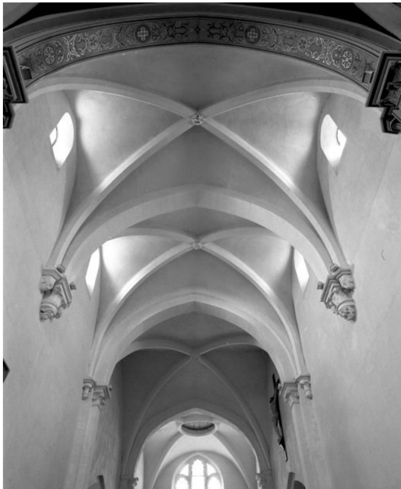
Vaisseau central, voûtes prises du choeur. 71, Gergy Eglise
