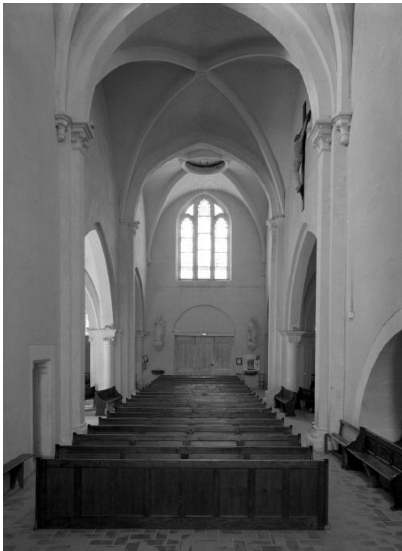
Vue d'ensemble depuis le chœur.
