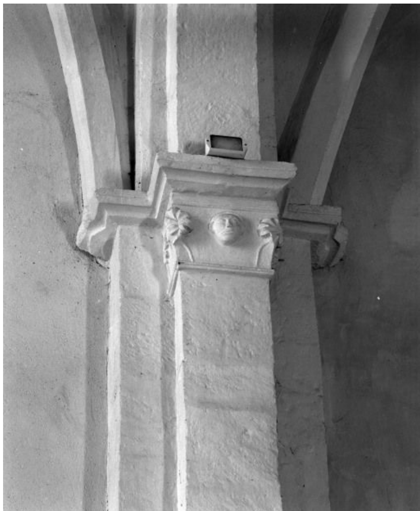
Nef, vaisseau central, chapiteau gauche du 1er arc doubleau.
