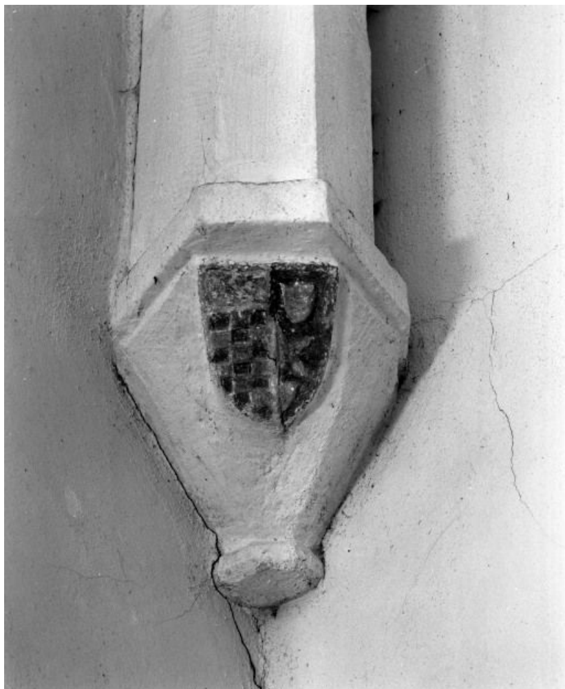
Bas-côté gauche (nord), 1ère travée, culot de l'angle antérieur gauche. 71, Gergy Eglise
