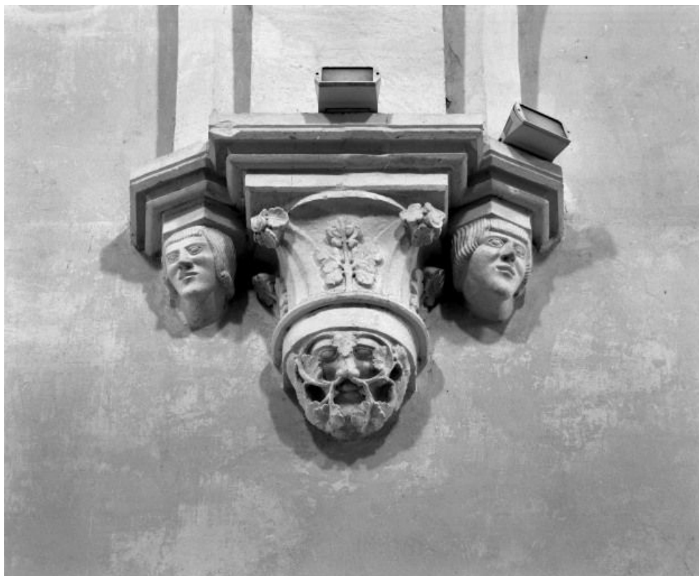
Avant-choeur, mur gauche : culots situés entre les 2 travées.
