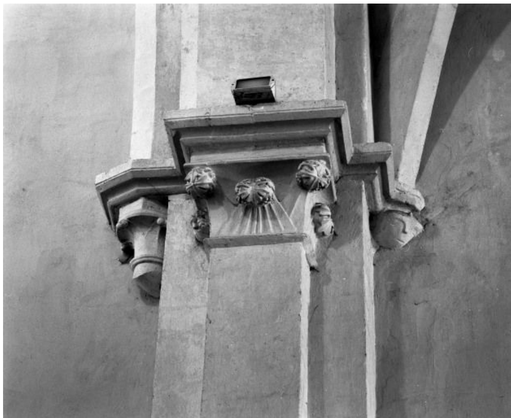
Nef, vaisseau central, chapiteau droit du 2e arc doubleau.
