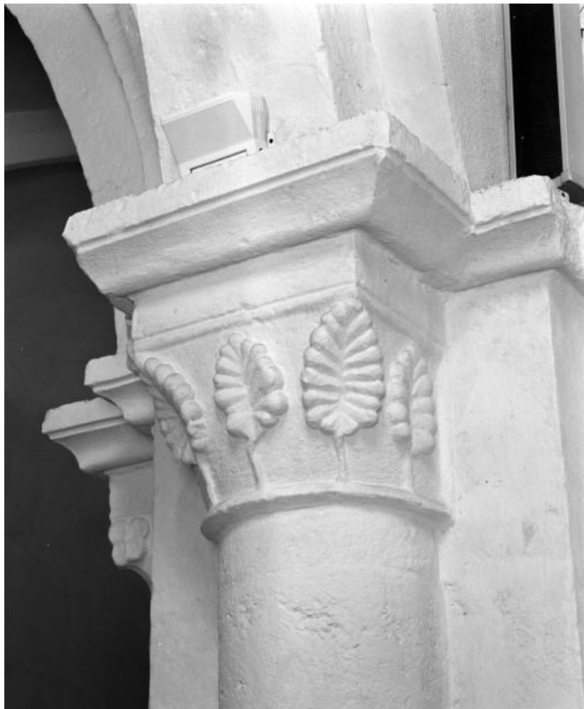
Vaisseau central de la nef, 1ère arcade gauche, chapiteau postérieur. 71, Gergy Eglise
