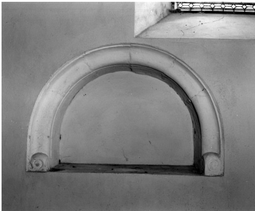
Chapelle du bas-côté droit (sud), niche lavabo. 71, Gergy Eglise
