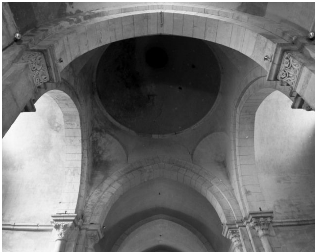
Croisée du transept : coupole sur trompes.
