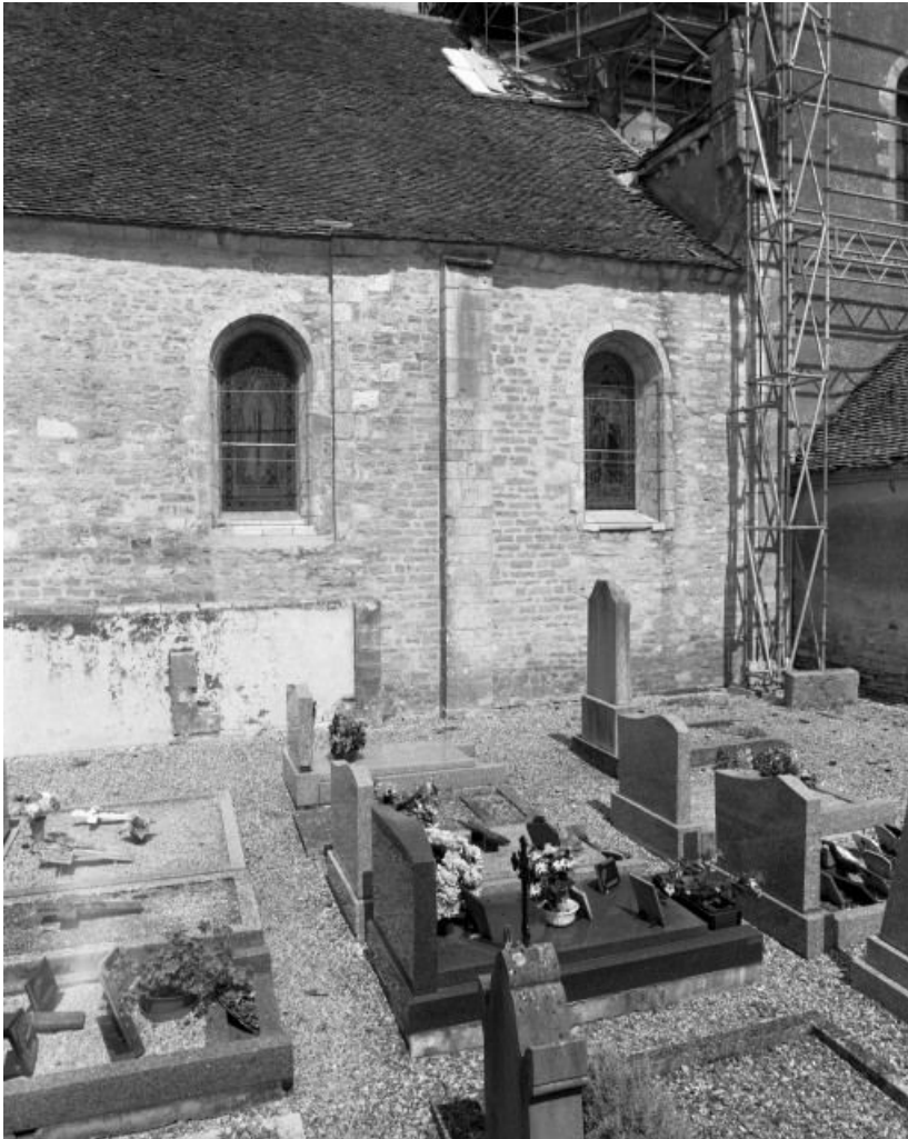
Elévation droite (sud) des 4e et 5e travées de la nef : traces de reprises dans la maçonnerie, partie inférieure de l'ancien mur et d'un portail sous la fenêtre gauche.
