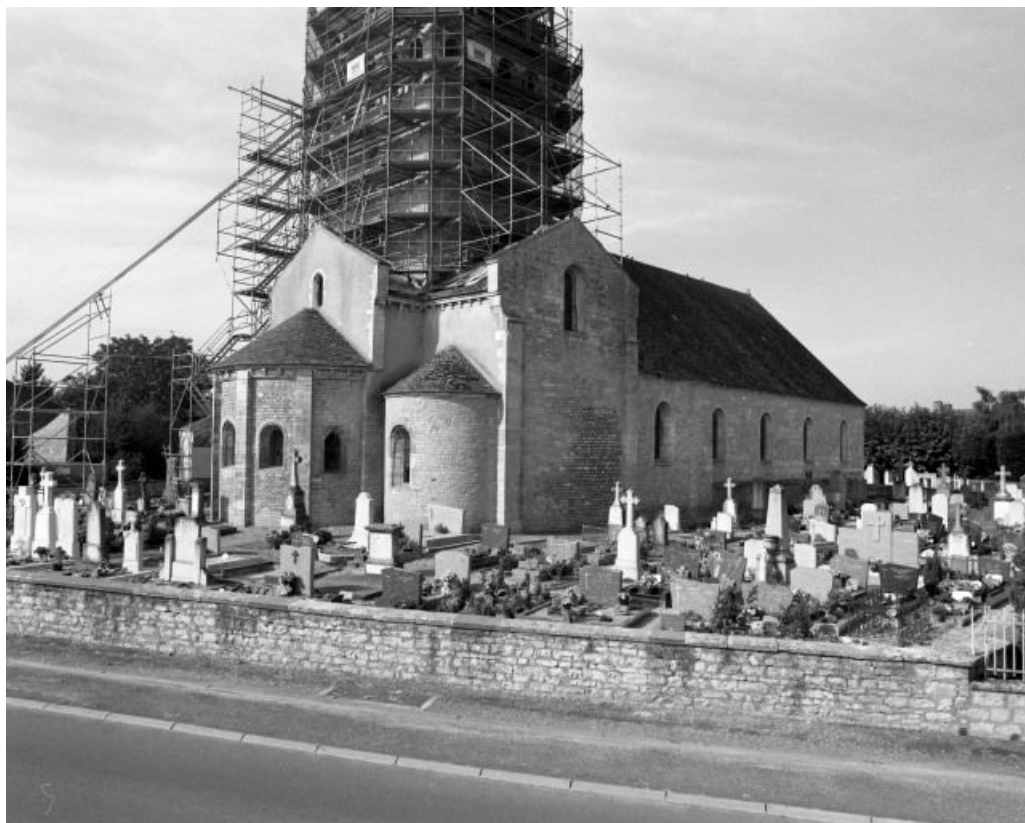
Vue de l'église et du cimetière prise du nord-est, pendant les travaux de réfection de la flèche. 71, Ciel C.D. 72
