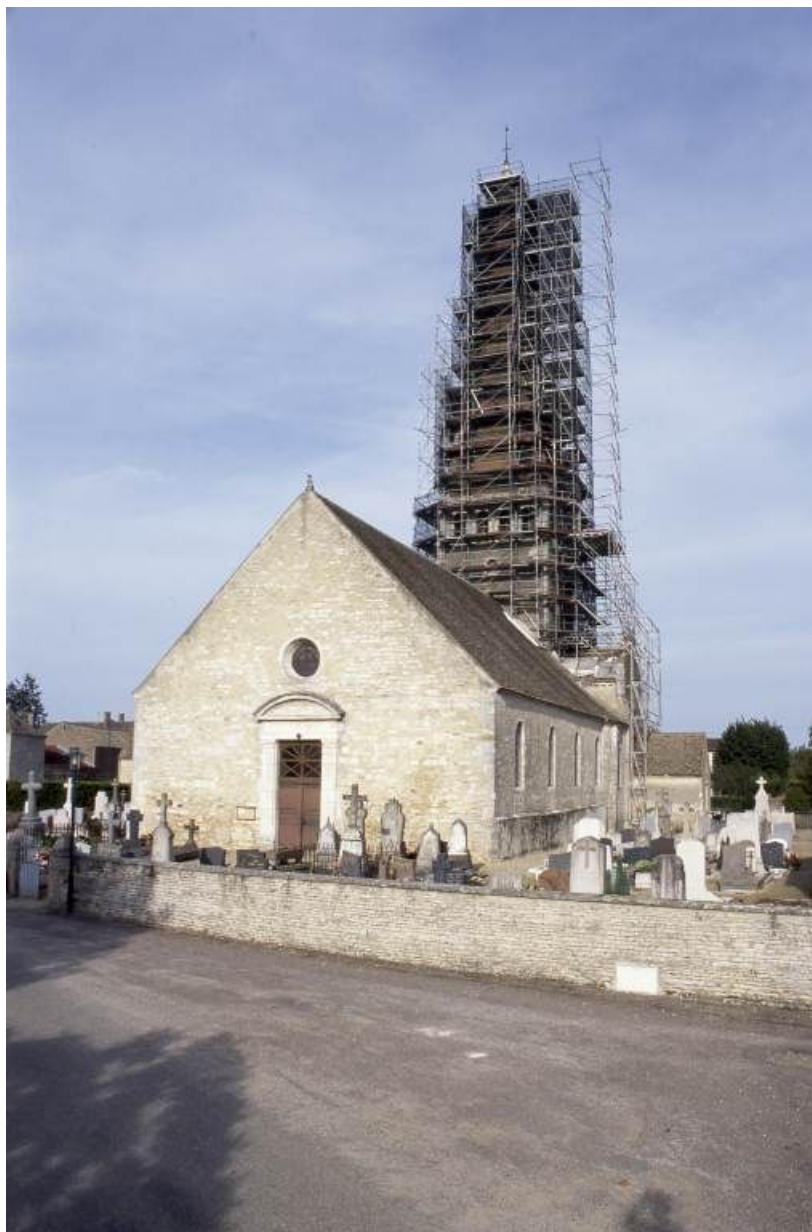
Vue prise du sud-ouest, pendant les travaux de réfection de la flèche. 71, Ciel C.D. 72
