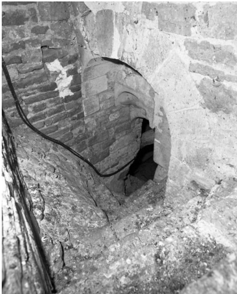
Clocher : escalier et passage donnant sur le comble de la nef.
