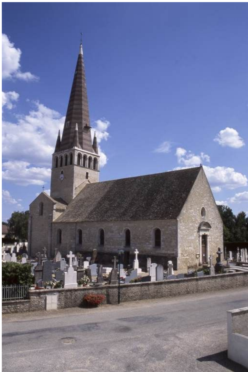
Vue d'ensemble : façade et élévation gauche.
