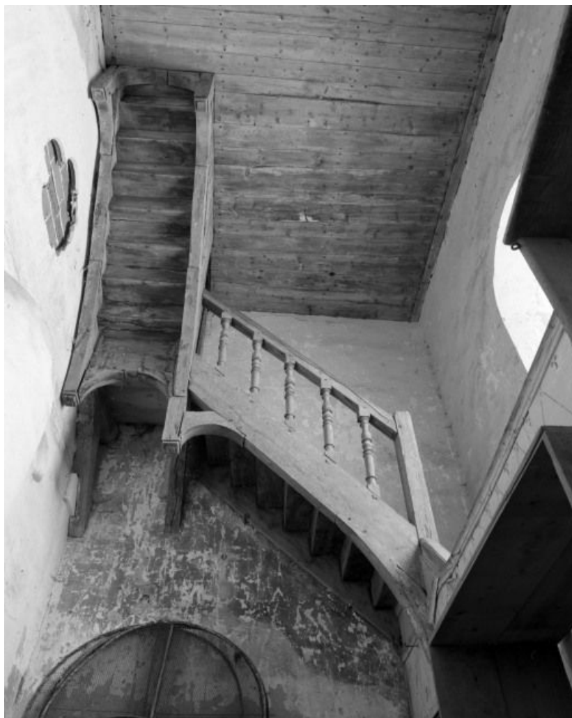
Bas-côté gauche, 1ère travée : escalier d'accès aux combles.
