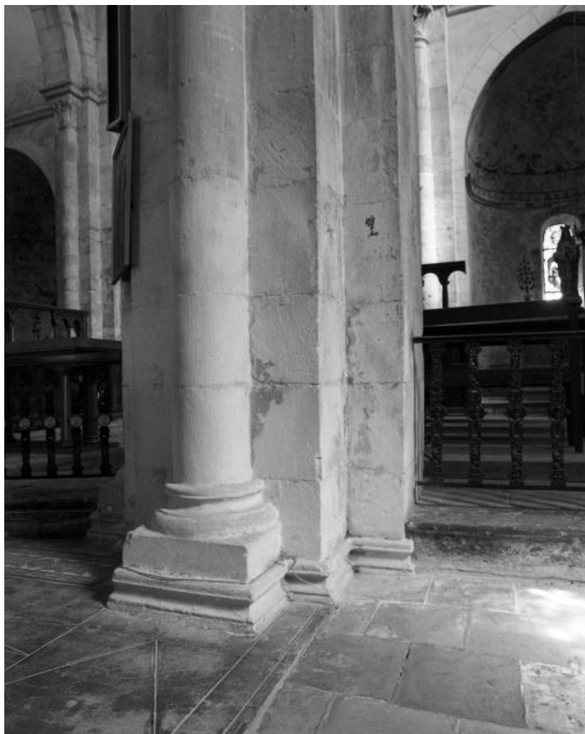
Nef, 5e arcade droite : base de la colonne engagée nord.
