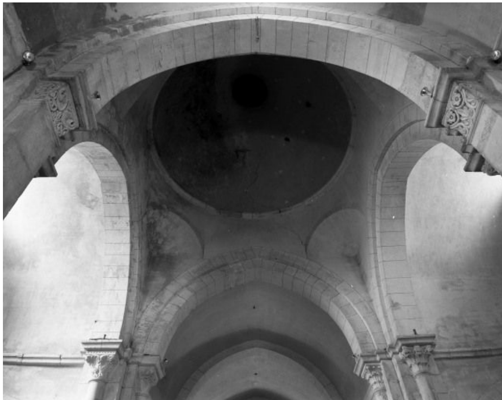
Croisée du transept : coupole sur trompes.
