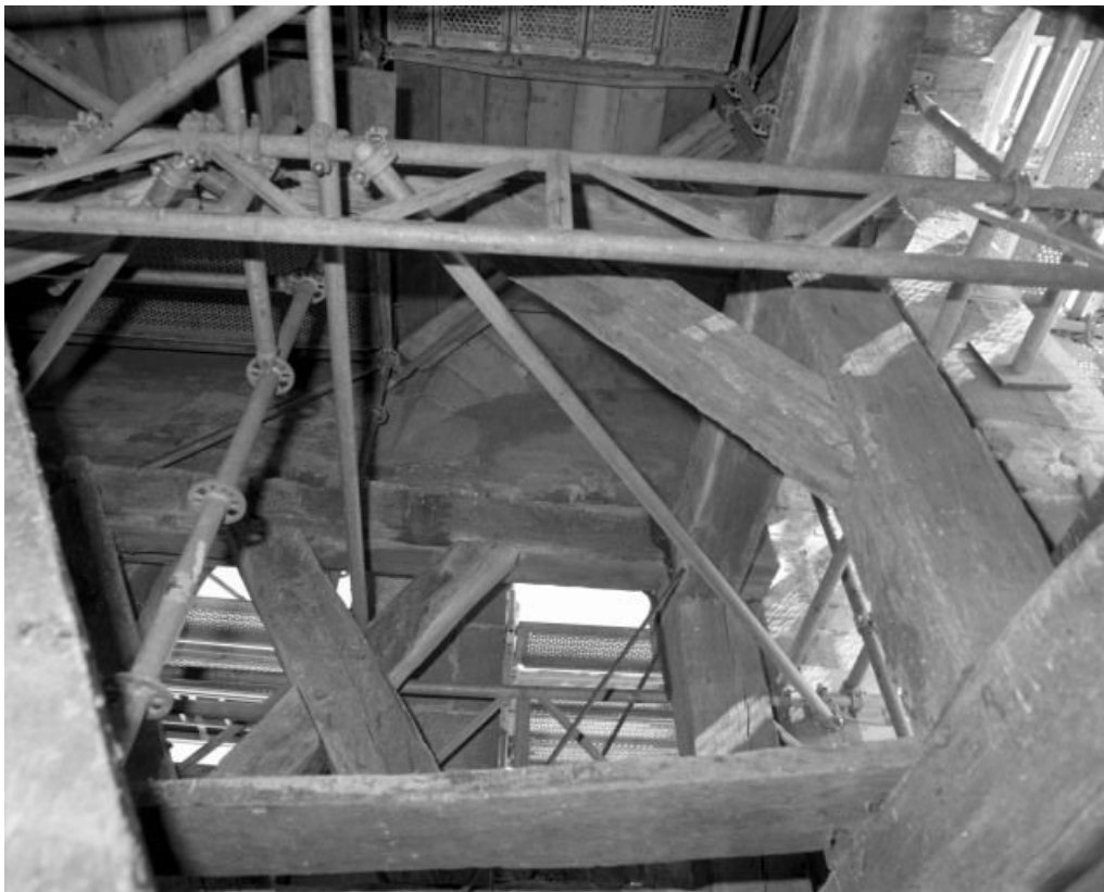
Clocher : support dans l'angle nord-est (vue prise pendant les travaux). 71, Ciel C.D. 72
