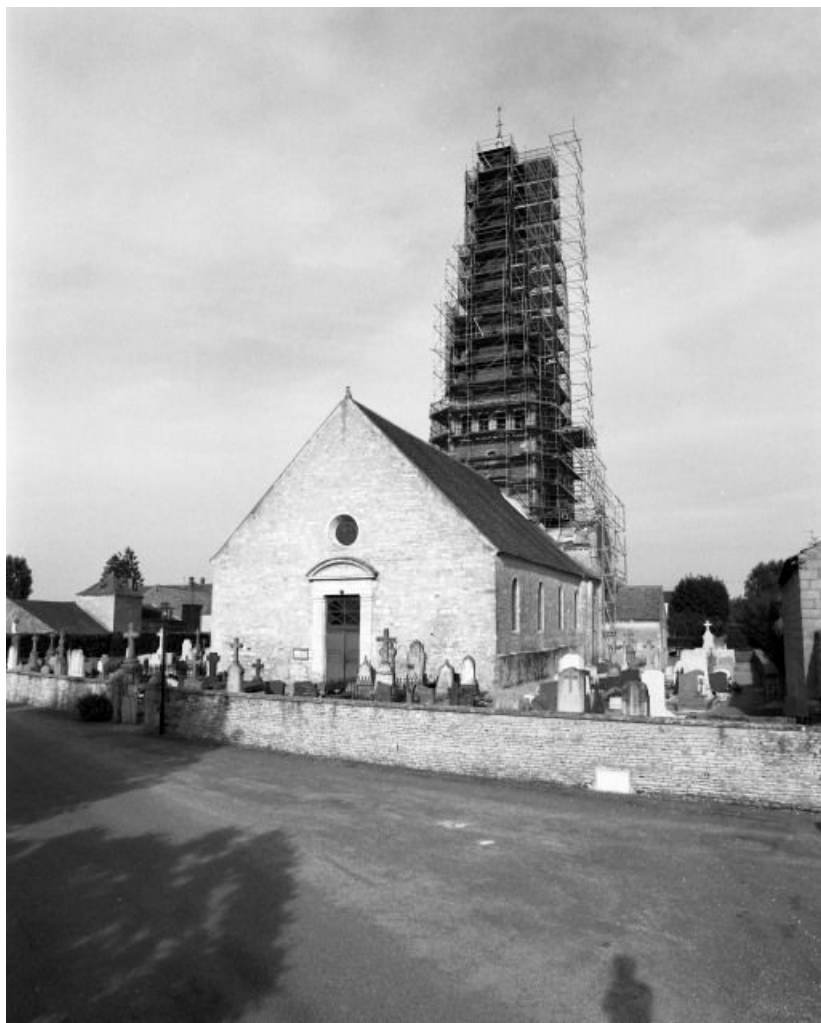
Vue prise du sud-ouest, pendant les travaux de réfection de la flèche. 71, Ciel C.D. 72
