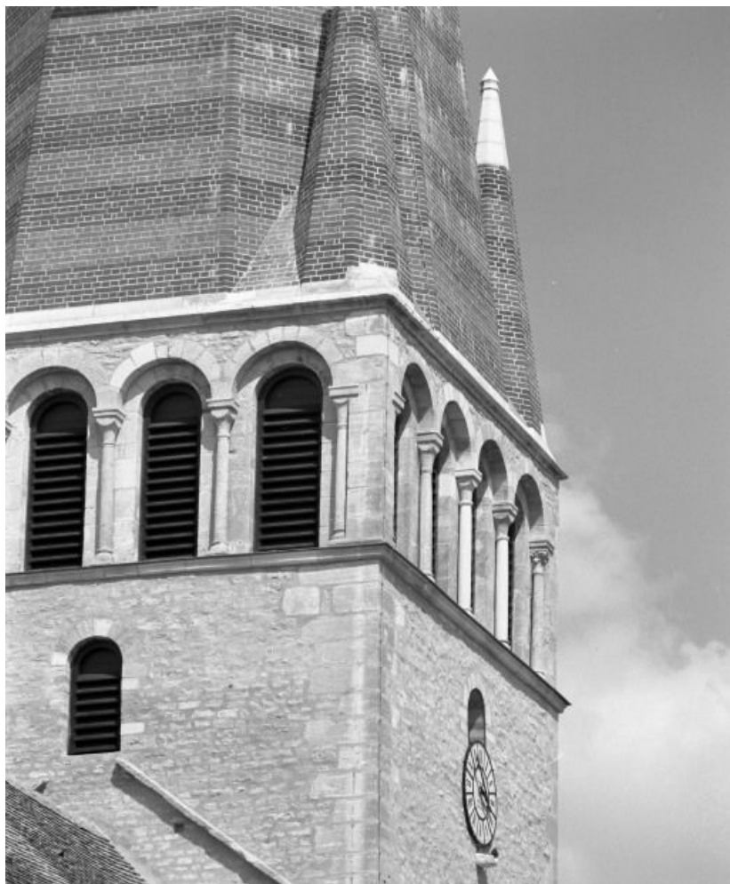
Clocher : détail des baies de la face droite.
