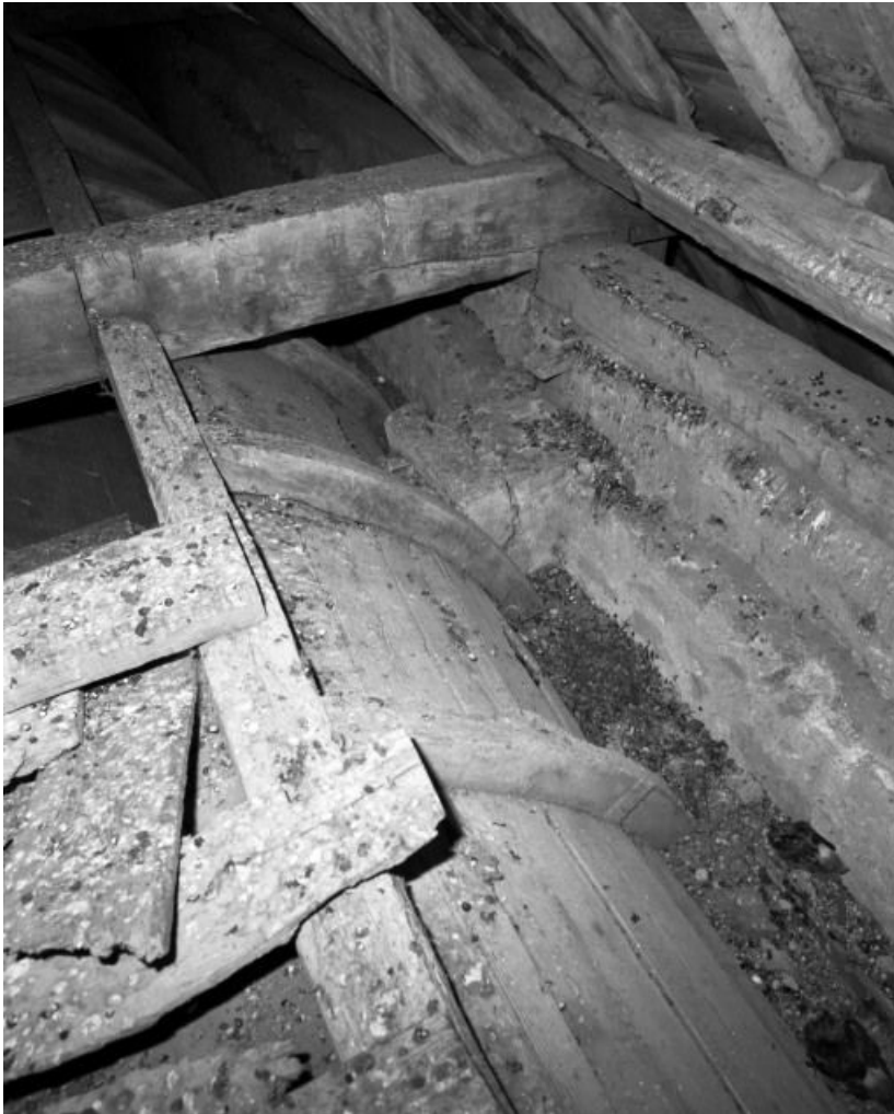
Comble du vaisseau central de la nef : section de lambris cintrée.
