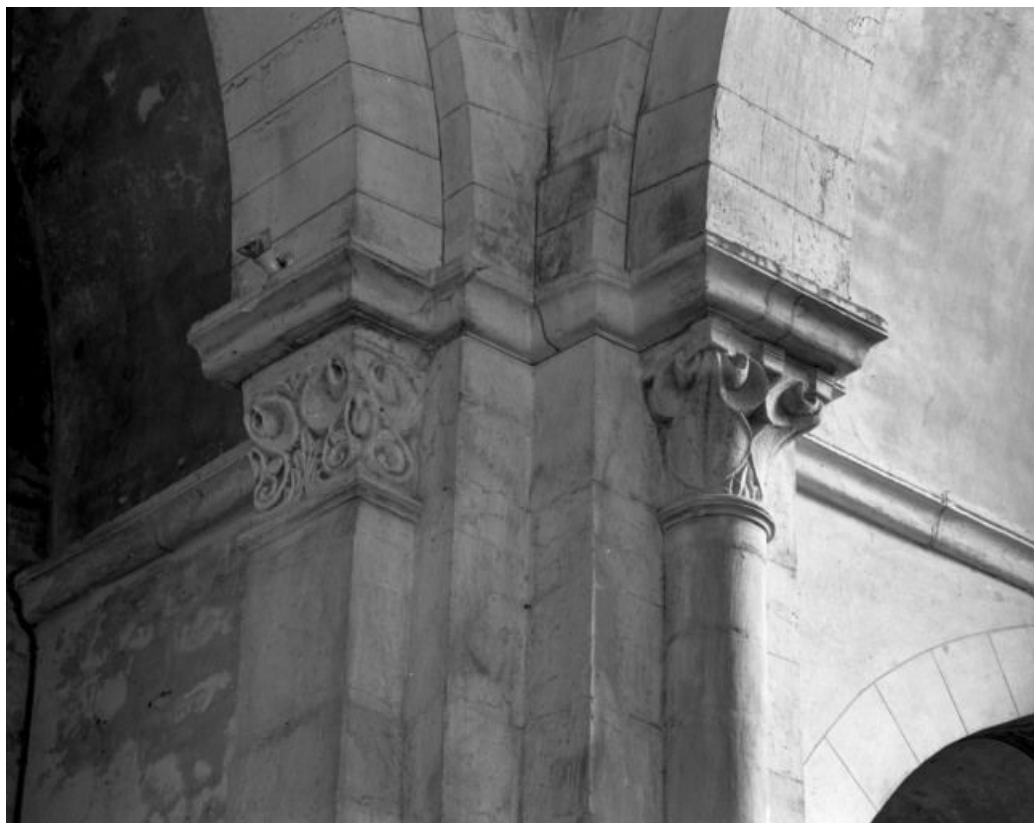
Croisée du transept : chapiteaux de l'angle nord-est.
