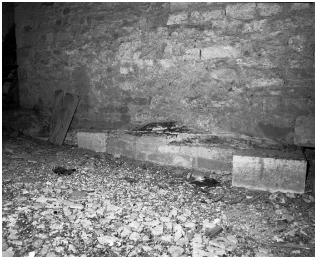
Comble du bas-côté gauche : mur du vaisseau central de la nef.
