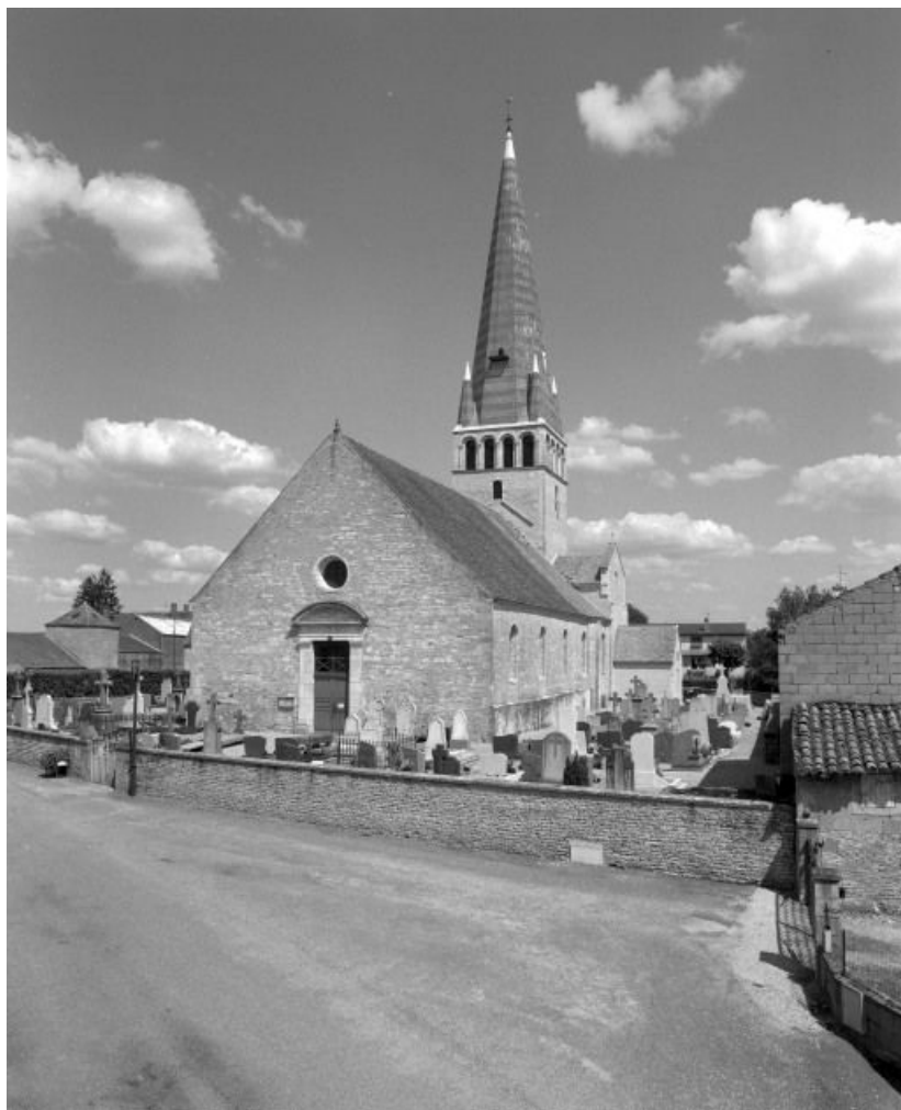
Vue d'ensemble : façade et élévation droite.
