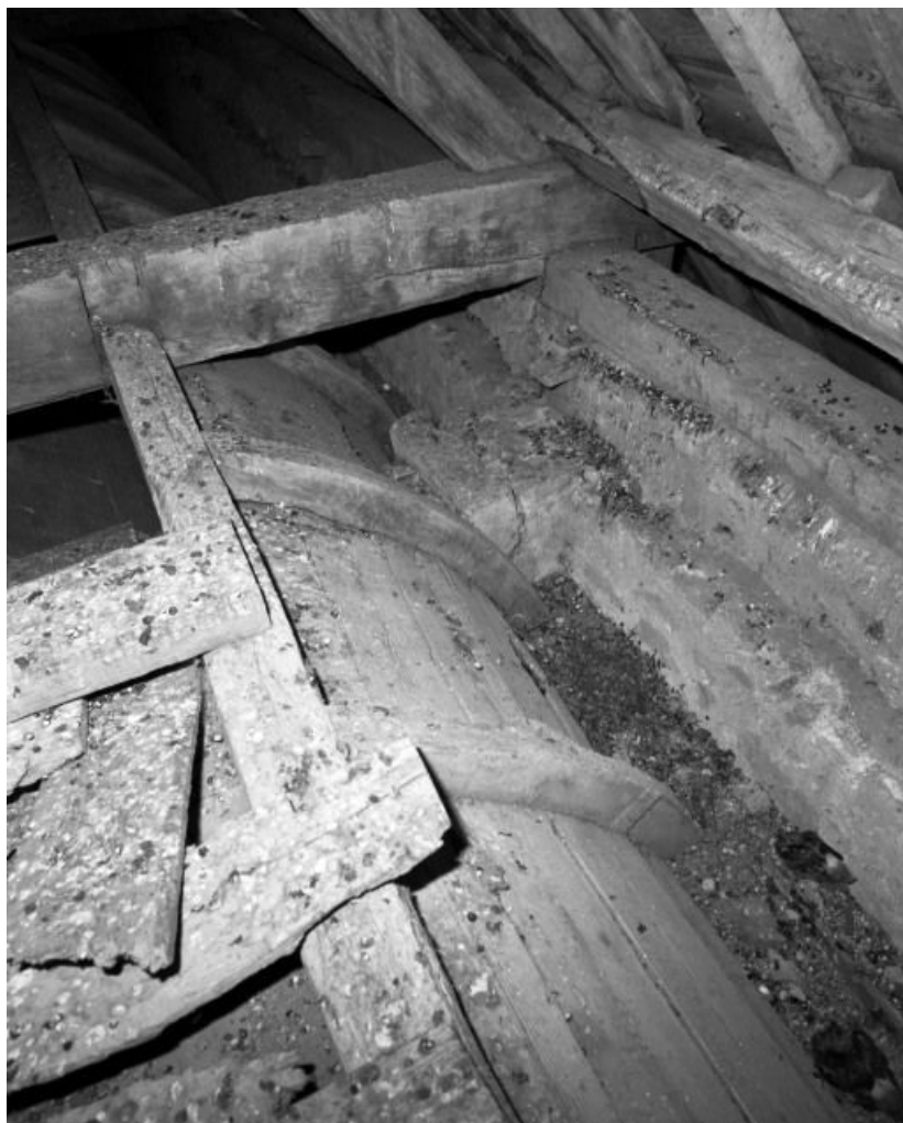
Comble du vaisseau central de la nef : section de lambris cintrée. 71, Ciel C.D. 72
