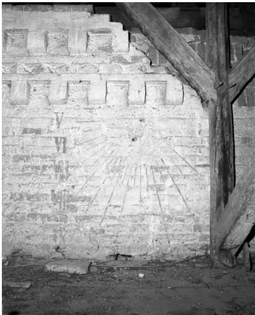
Comble de la chapelle droite : cadran solaire.
