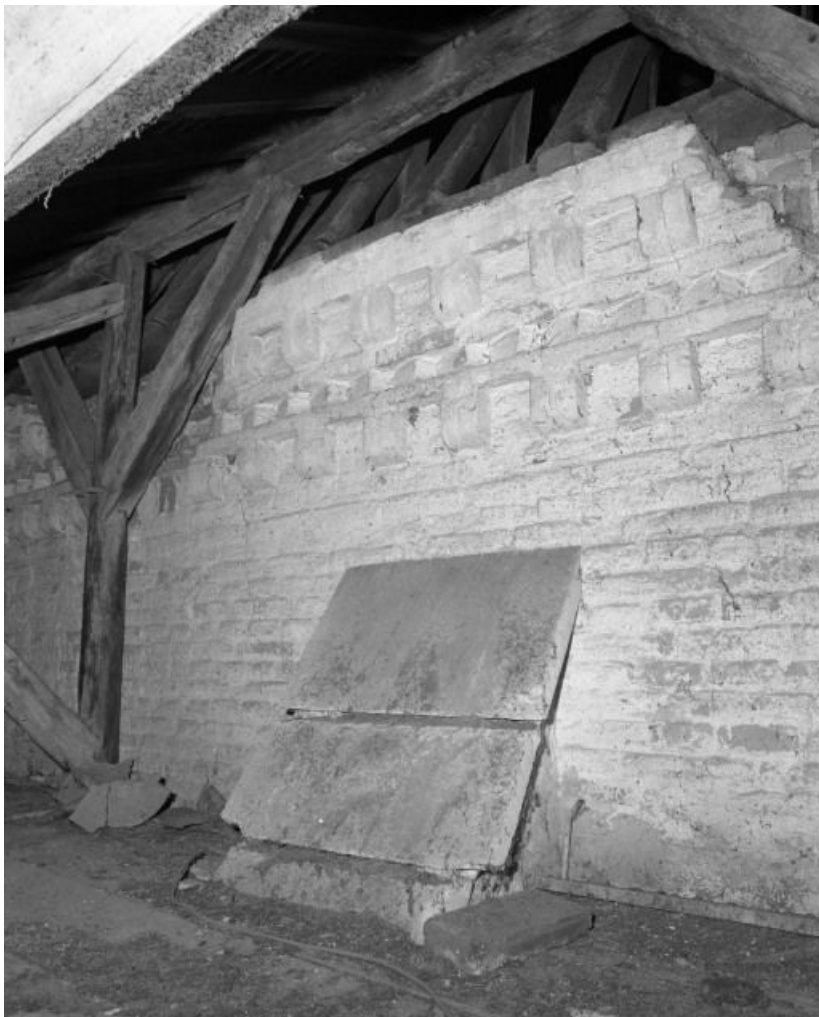
Comble de la chapelle droite : chaperon d'un contrefort.
