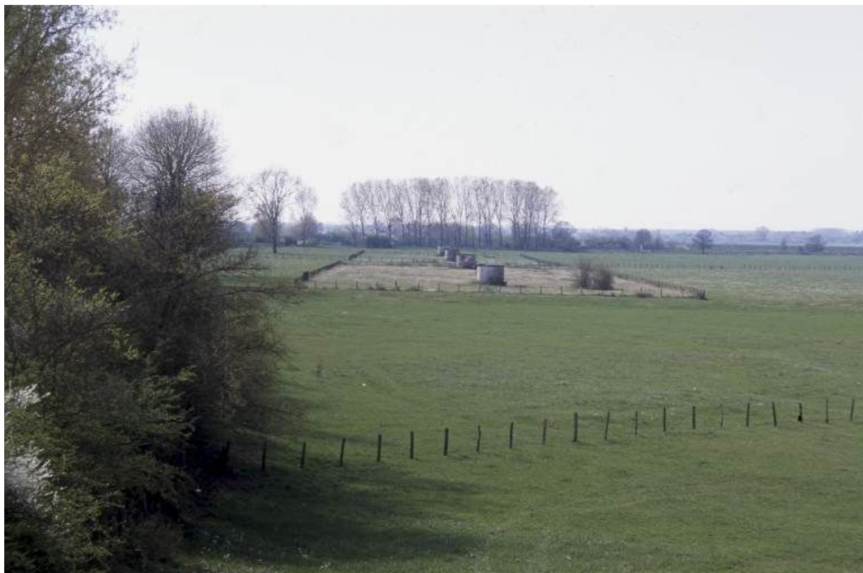
Puits et captage des eaux construits au bord de Saône vers 1953-54.
