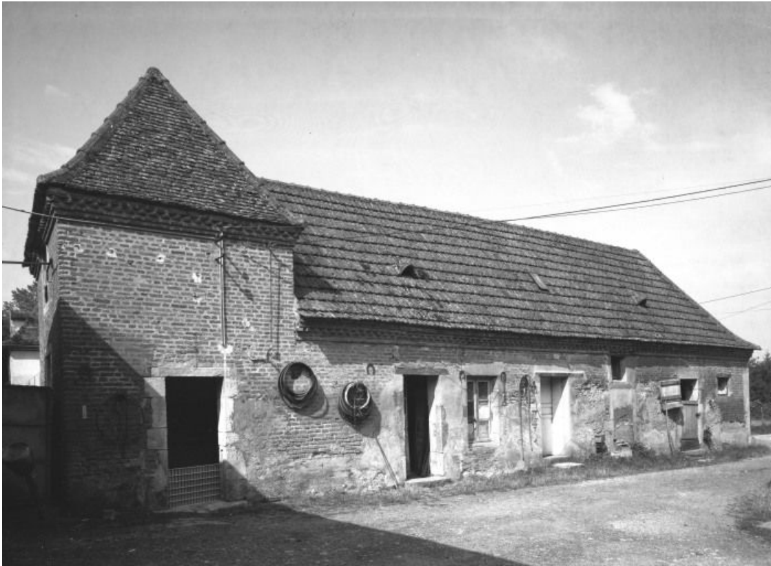
Logis du garçon de ferme et étables.
