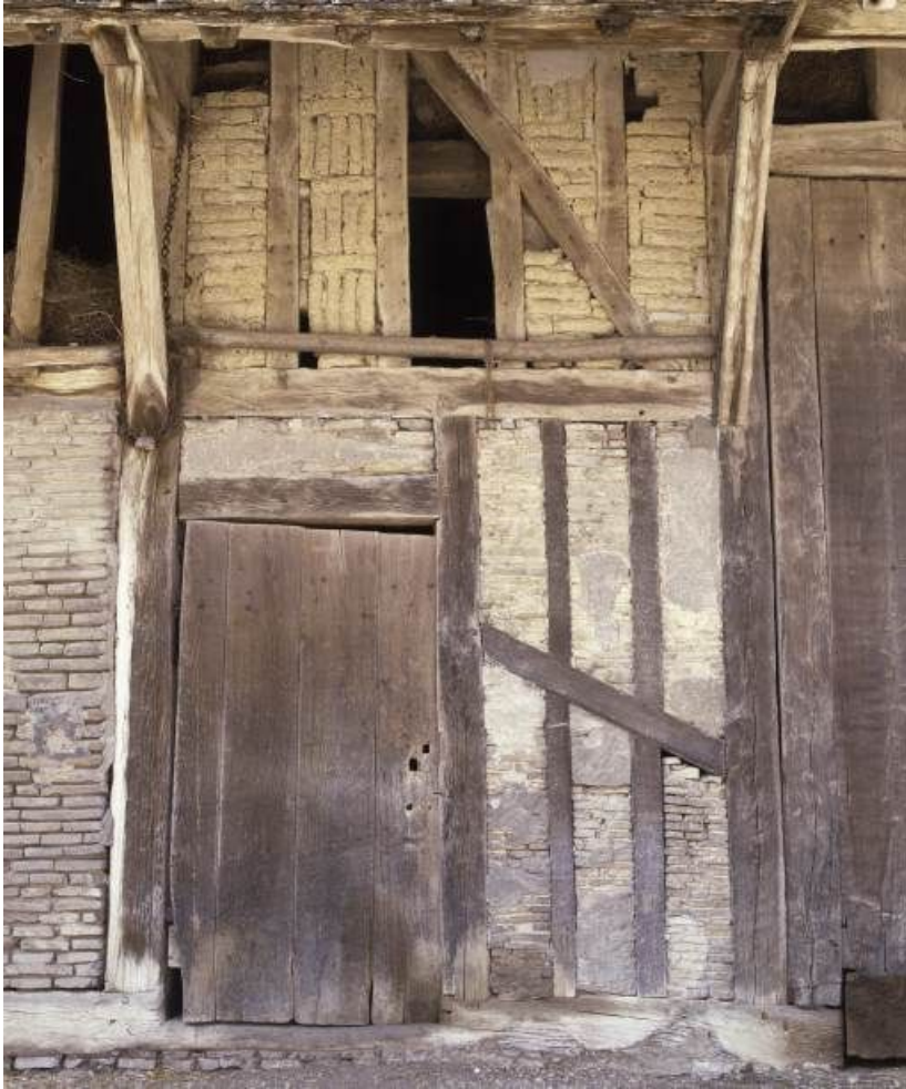
Bâtiment des dépendances, détail.
