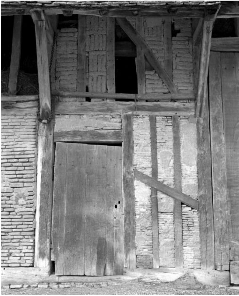
Bâtiment des dépendances, détail.
