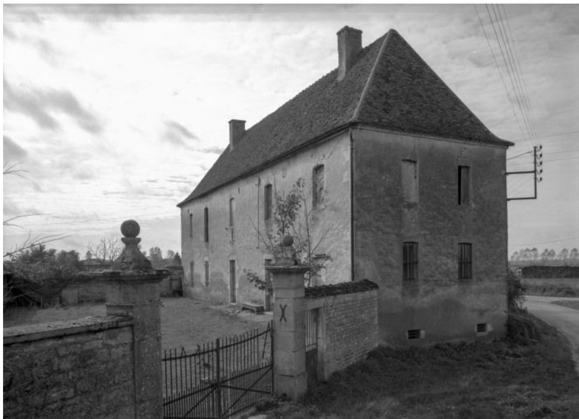
Portail et bâtiment d'habitation.
