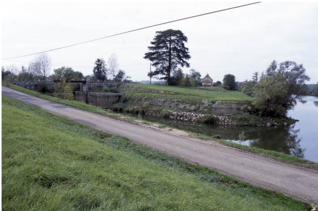
L'entrée est de l'écluse, à gauche du Pasquier du bief.
