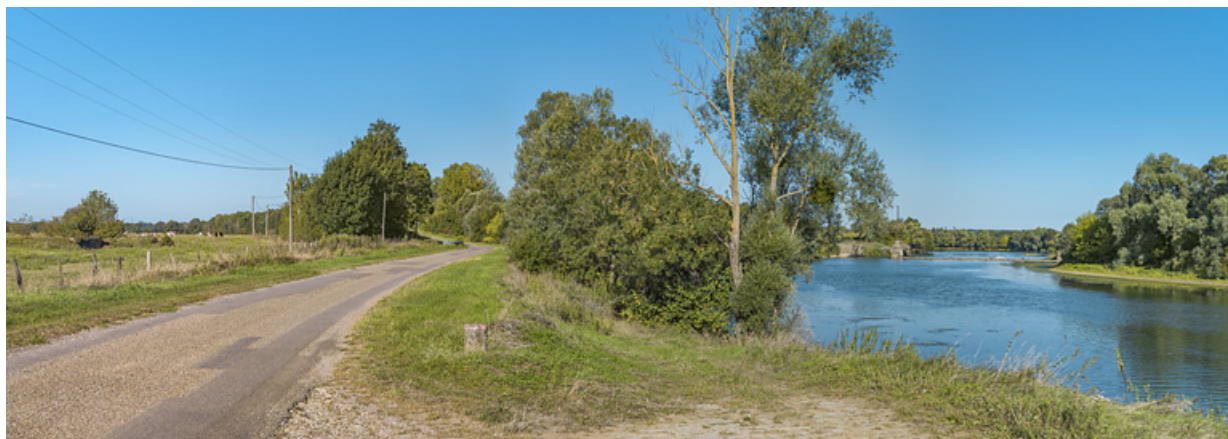
Vue d'amont de l'ancien barrage au niveau de l'entrée de la dérivation, en 2019.
