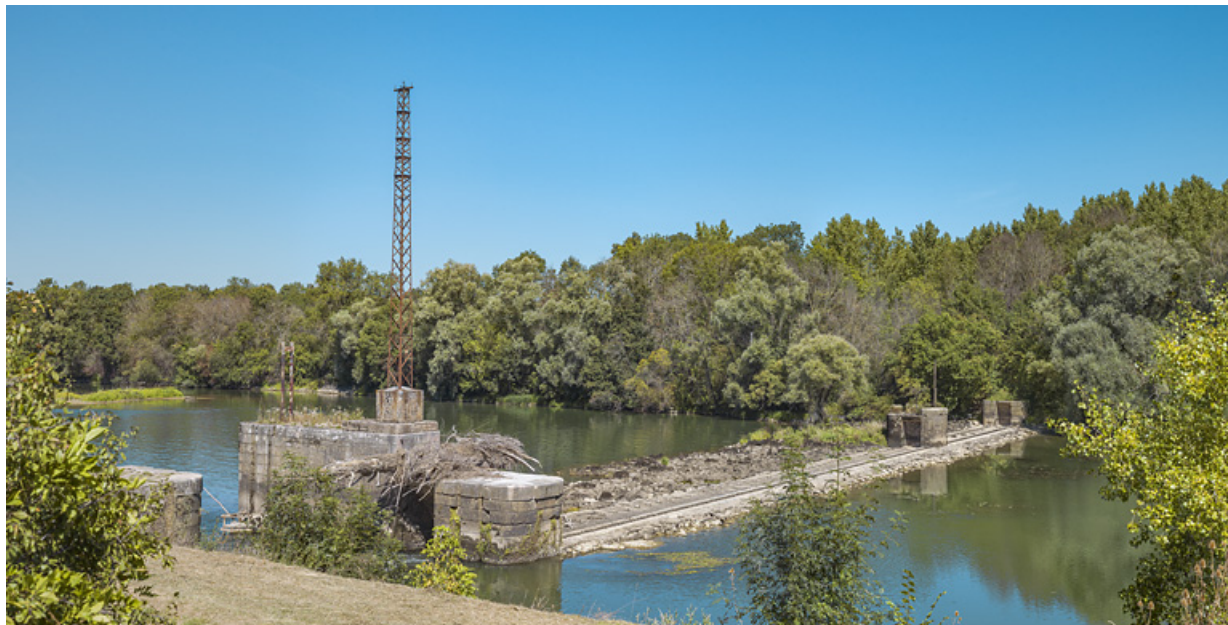
Vue d'ensemble du barrage, avec à gauche le pertuis, en 2019.
