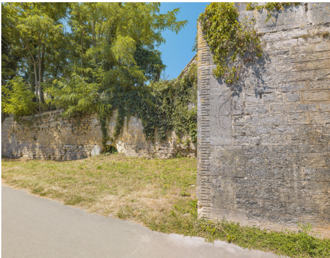
Détail de l'échelle de crue sur le pylône de la rive droite.
