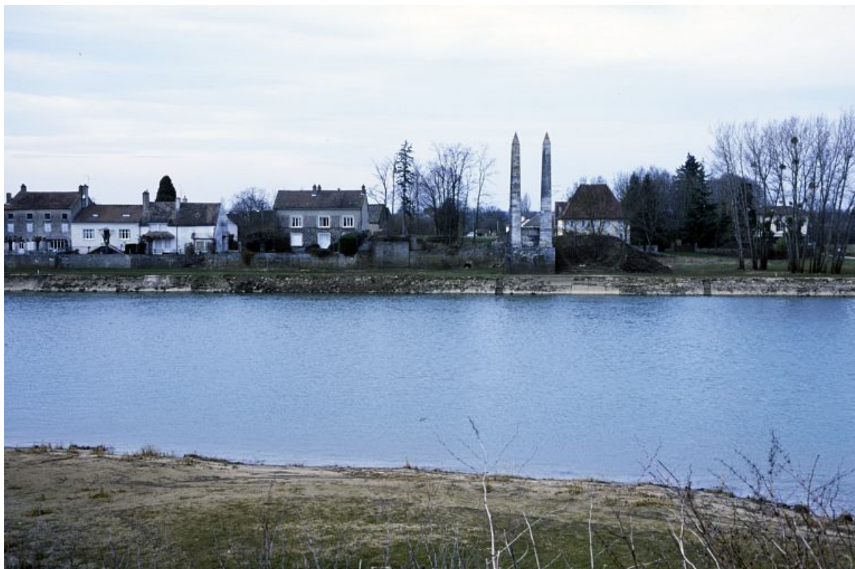
Pylônes, vestiges du pont suspendu en 2003.
