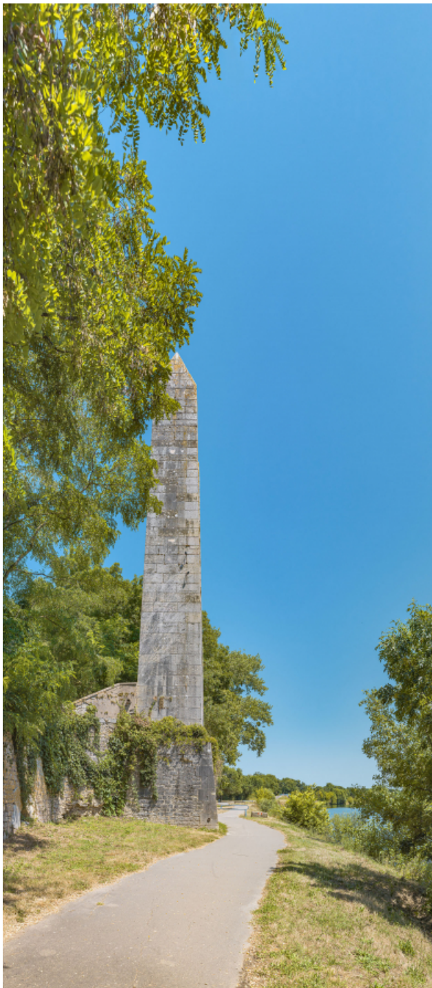
Pylônes de la rive droite, le long de la digue de Chauvort.
