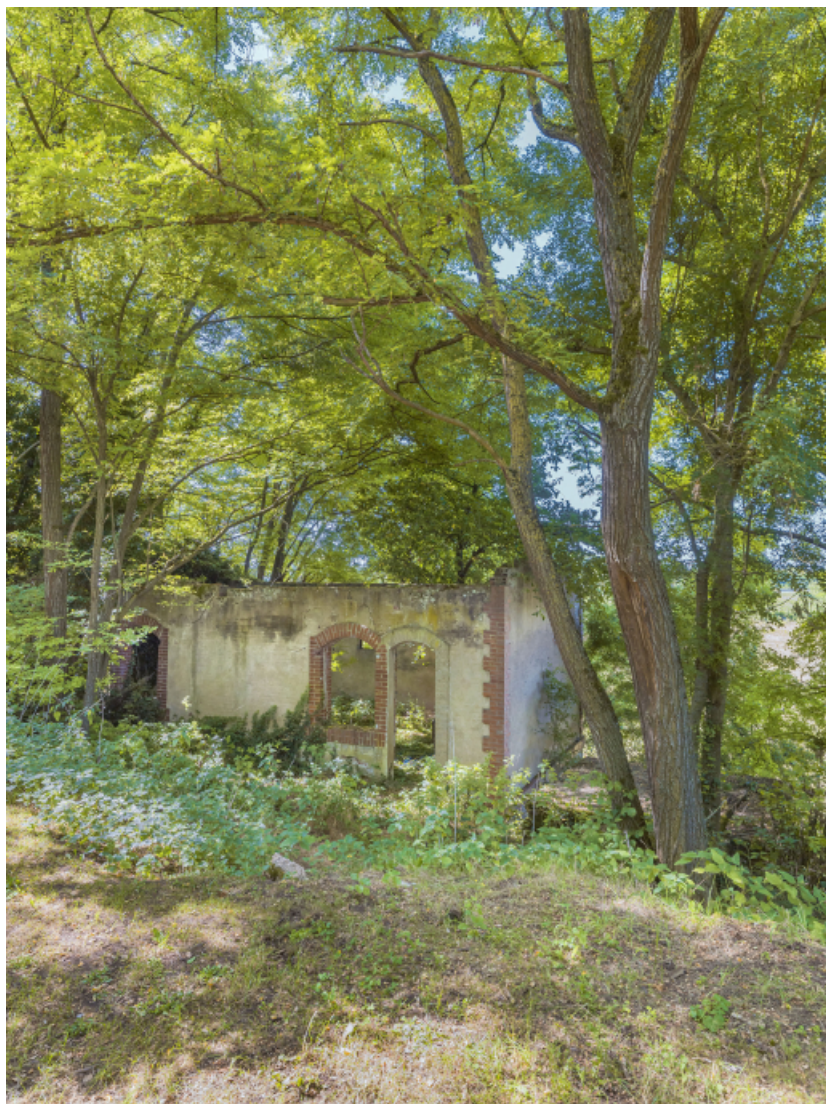
Vestiges d'un bâtiment (magasin ?), rive gauche.
