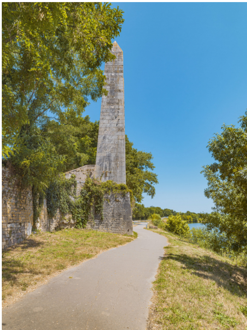
Pylônes de la rive droite, le long de la digue de Chauvort.
