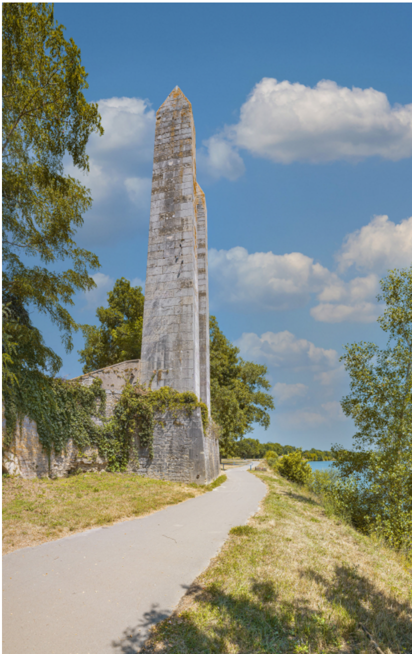
Pylônes de la rive droite, le long de la digue de Chauvort.
