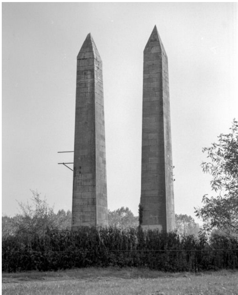
Pylones de la rive droite, vue prise de l'ancienne route n° 470
