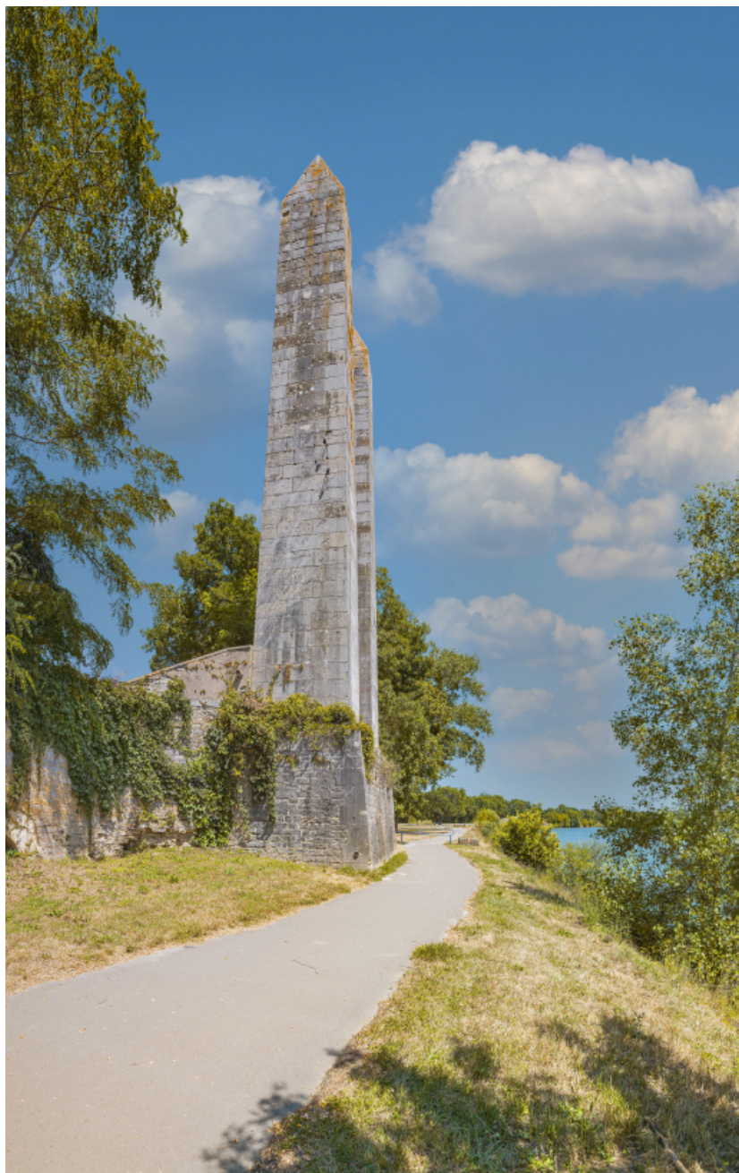
Pylônes de la rive droite, le long de la digue de Chauvort.
