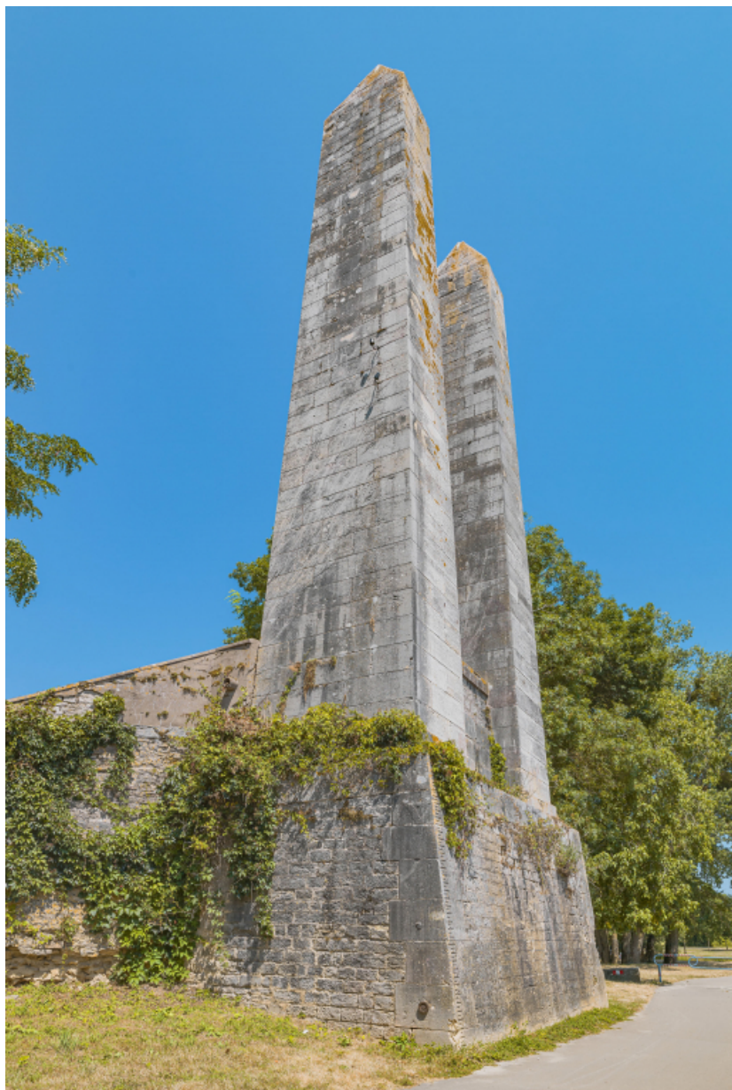
Pylônes de la rive droite, le long de la digue de Chauvort. Echelle de crue. 71, Allerey-sur-Saône, lieudit : Chauvort
