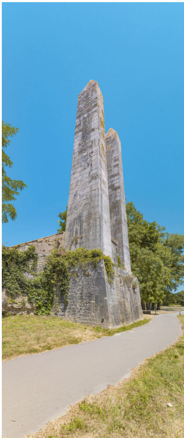
Pylônes de la rive droite, le long de la digue de Chauvort. Echelle de crue. 71, Allerey-sur-Saône, lieudit : Chauvort
