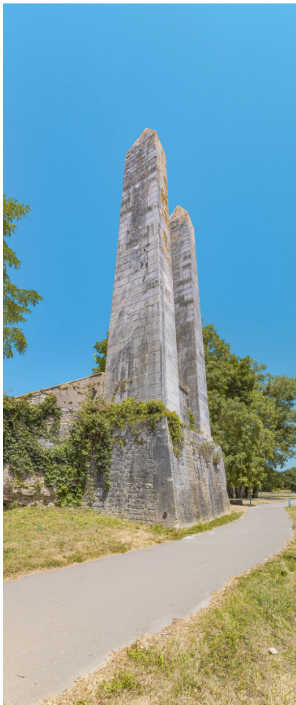
Pylônes de la rive droite, le long de la digue de Chauvort. Echelle de crue. 71, Allerey-sur-Saône, lieudit : Chauvort
