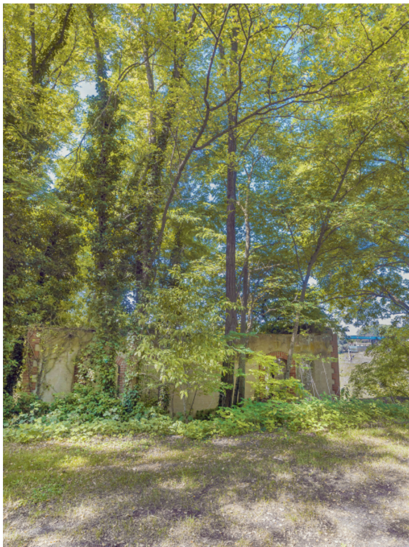
Vestiges d'un bâtiment (magasin ?), rive gauche.
