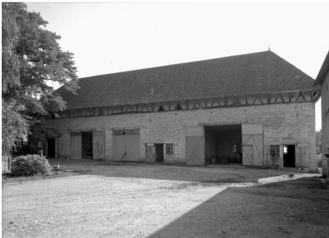
Dépendances, façade sur cour.
