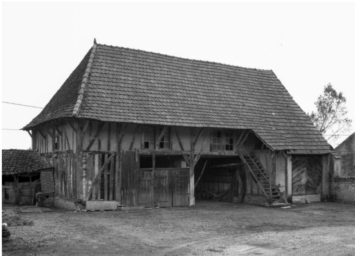
Bâtiment abritant les remises et le séchoir.
