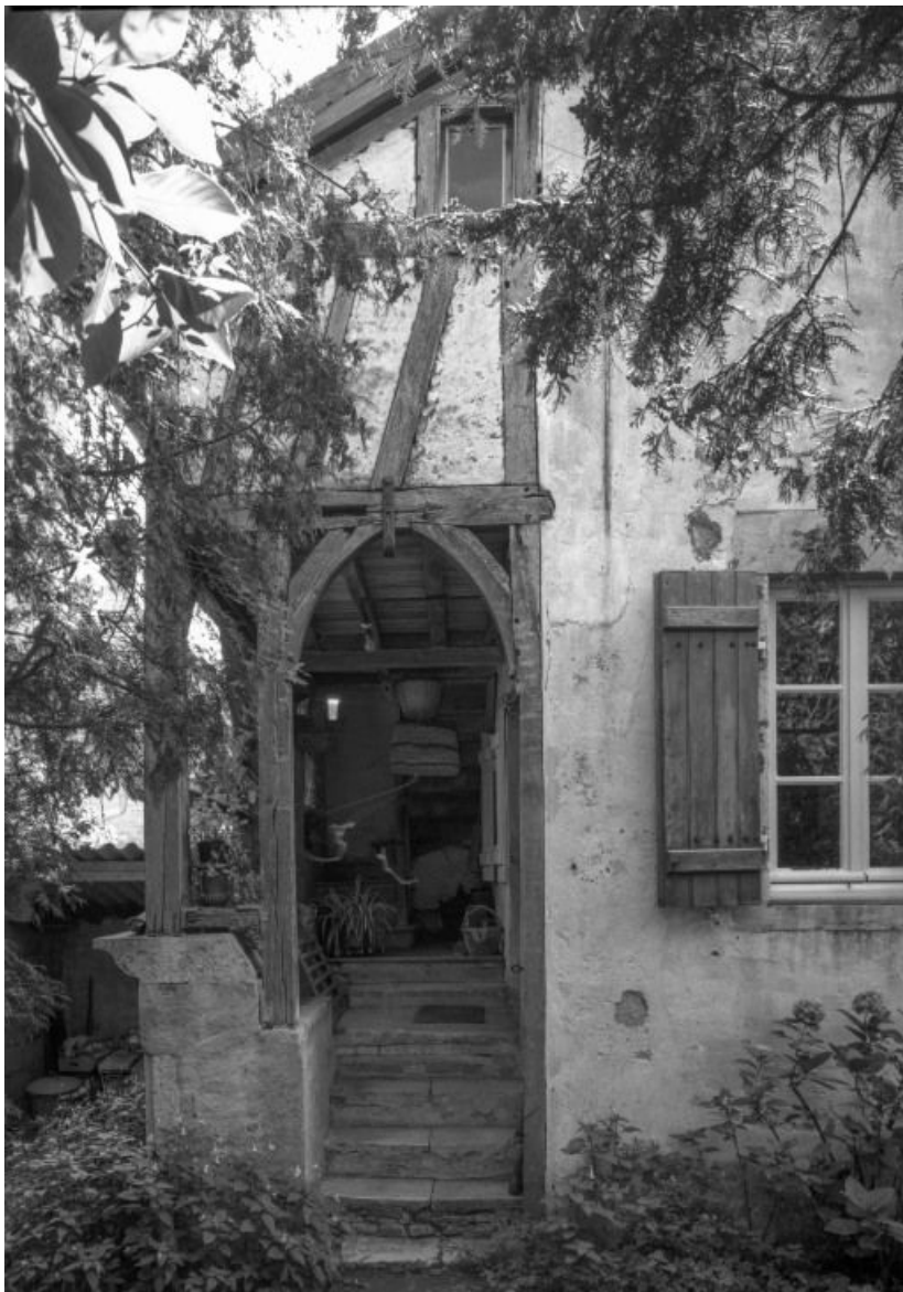
Ferme (1980 AO 115), bâtiment principal : galerie et comble en surplomb.
