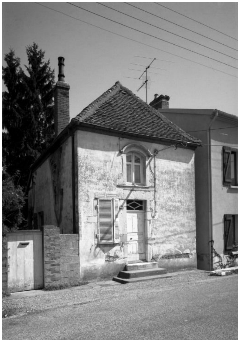
Ferme (1980 AO 115), bâtiment principal, façade sur rue.
