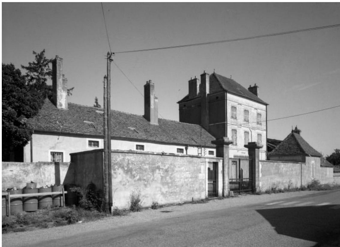
Ferme (1980 AO 14), mur de refend droit de la grange.
