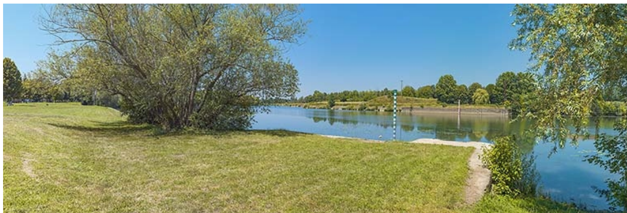
Culée de l'ancien barrage sur la rive gauche. On peut lire la tracé de l'ancien barrage jusqu'à l'ancienne écluse, rive droite. 71, Les Bordes rue de l' Ile, lieudit : PK 167,5
