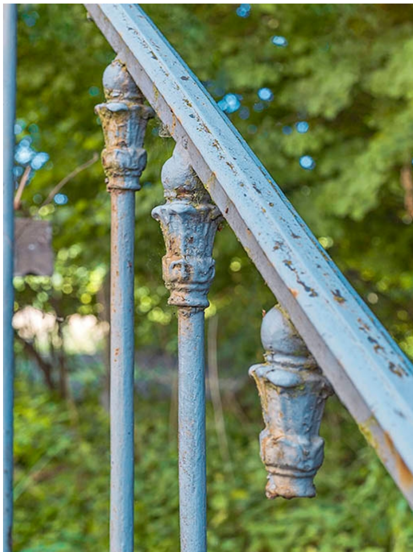
Détail des balustres du garde-corps de l'escalier.
