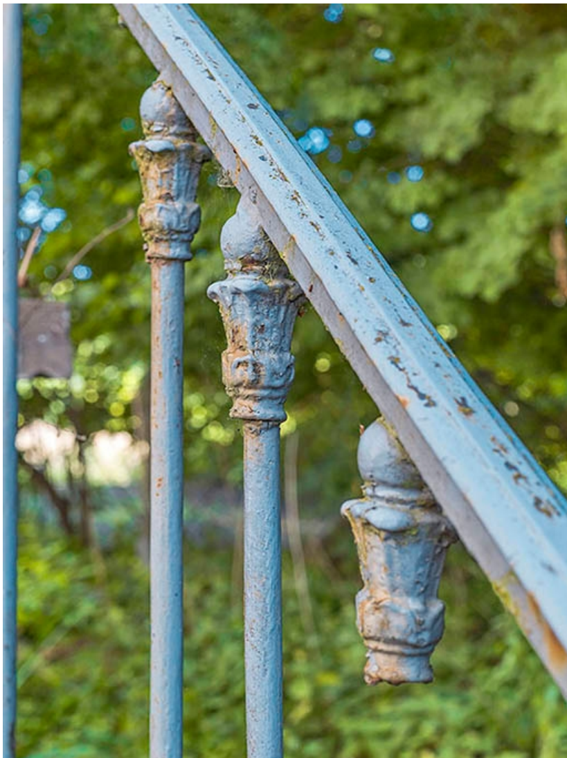
Détail des balustres du garde-corps de l'escalier.
