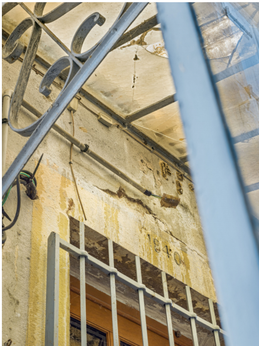
Détail de la marquise et du linteau de la porte d'entrée.
