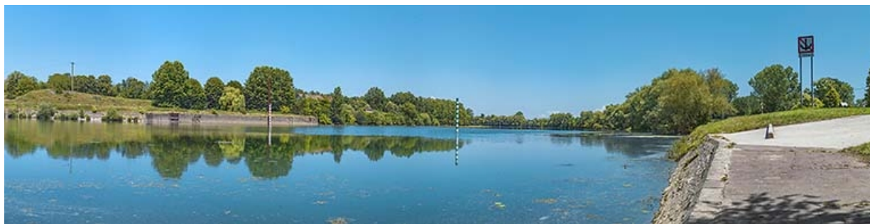
La Saône à hauteur de l'ancien barrage, en aval de la culée rive gauche.
