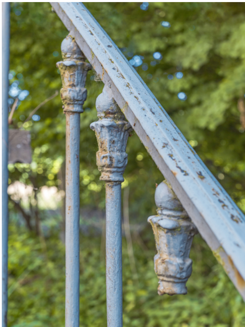
Détail des balustres du garde-corps de l'escalier.
