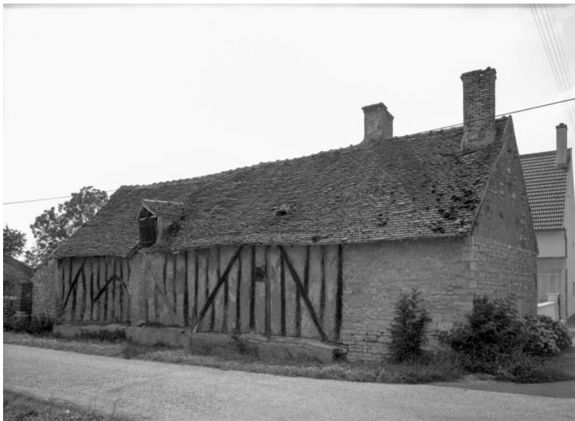
Chambre à four et remise.
