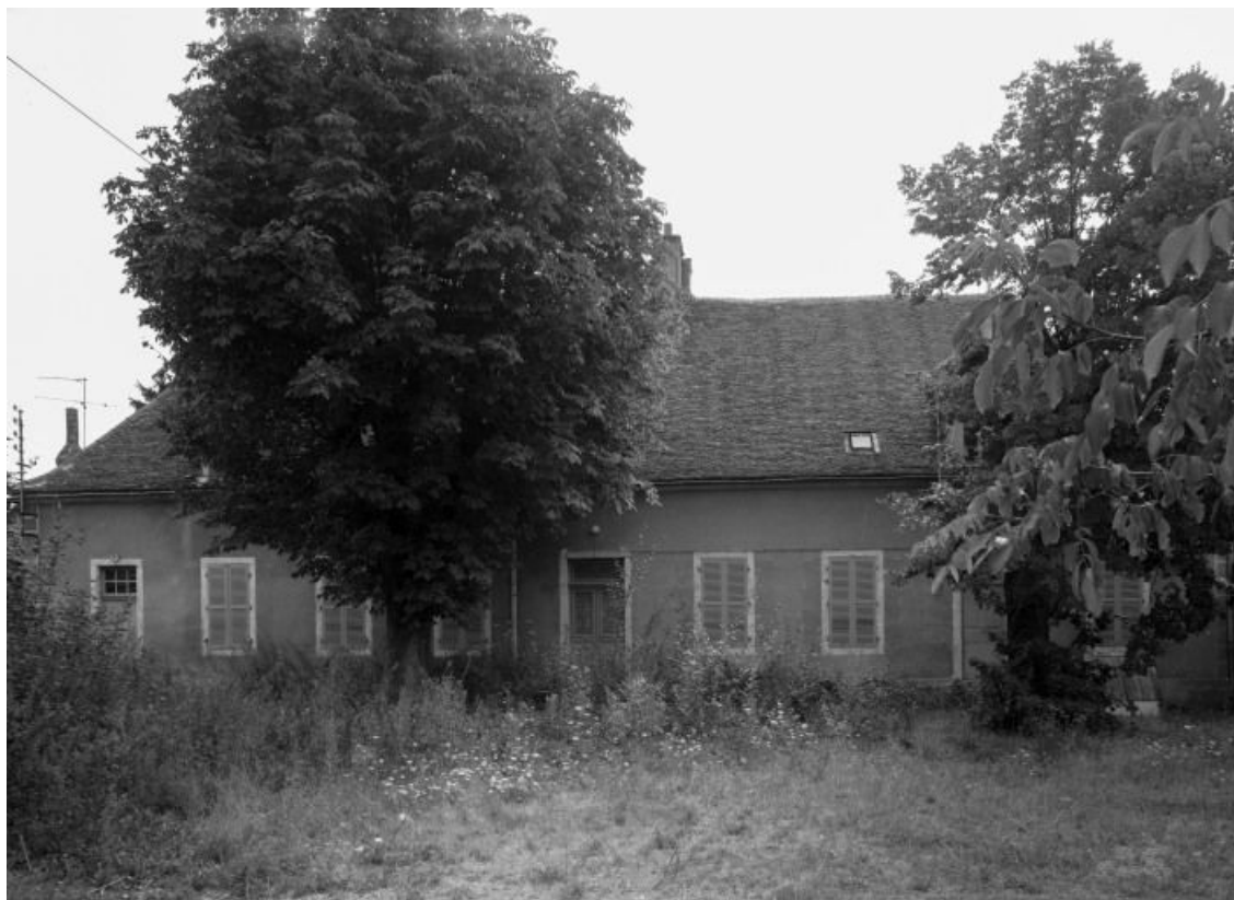
Bâtiment d'habitation, élévation antérieure.
