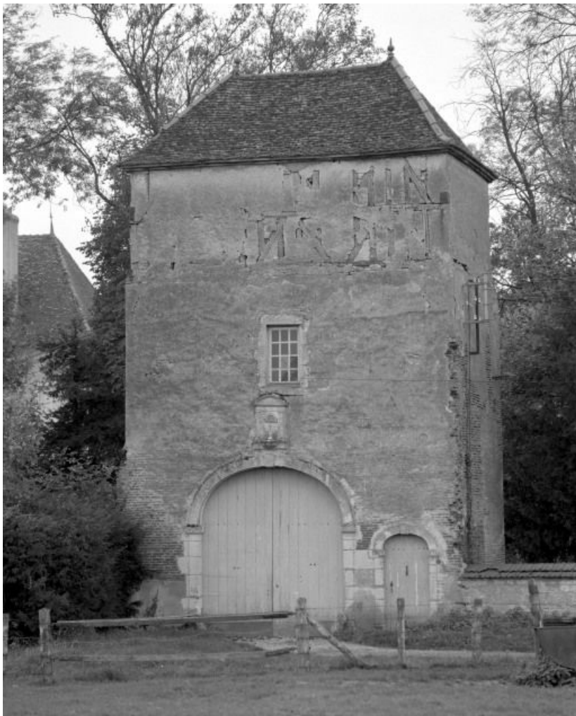
Corps de passage avec niche datée 1669.
