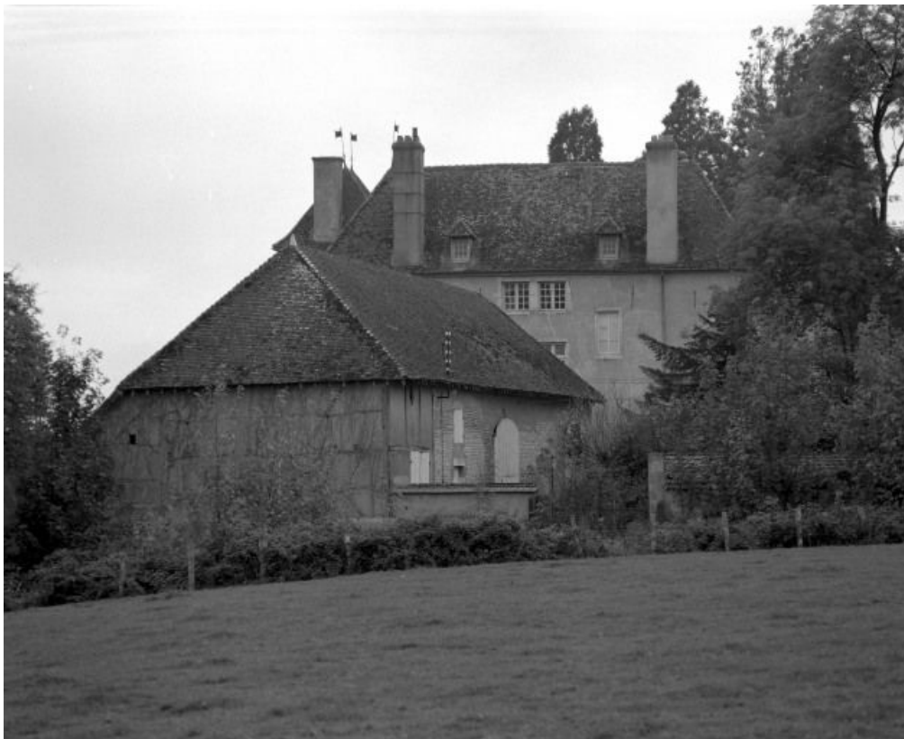
Bâtiment agricole à pan-de-bois et façade postérieure du château, vue prise du nord. 71, Gergy Château
