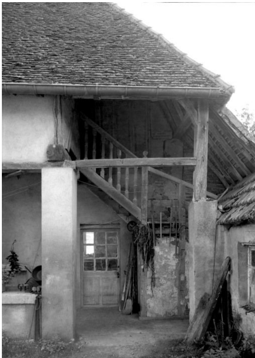
Bâtiment d'habitation, façade postérieure, escalier menant au comble.
