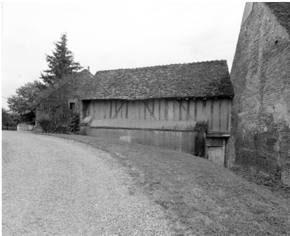
Bâtiment au fond de la cour : élévation postérieure sur cimetière.
