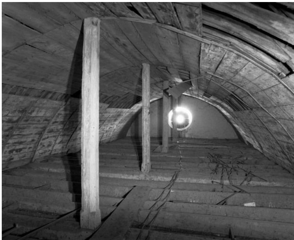
Comble de la nef, vue prise depuis le clocher.
