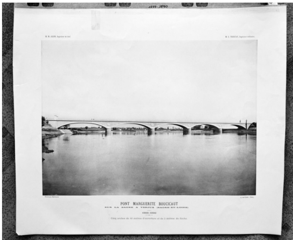
PONT MARGUERITE BOUCICAUT / sur la Saône à Verjux (Saône-et-Loire) / 1888-1890 / cinq arches de 40 mètres d'ouverture et de 5 mètres de flèche..
