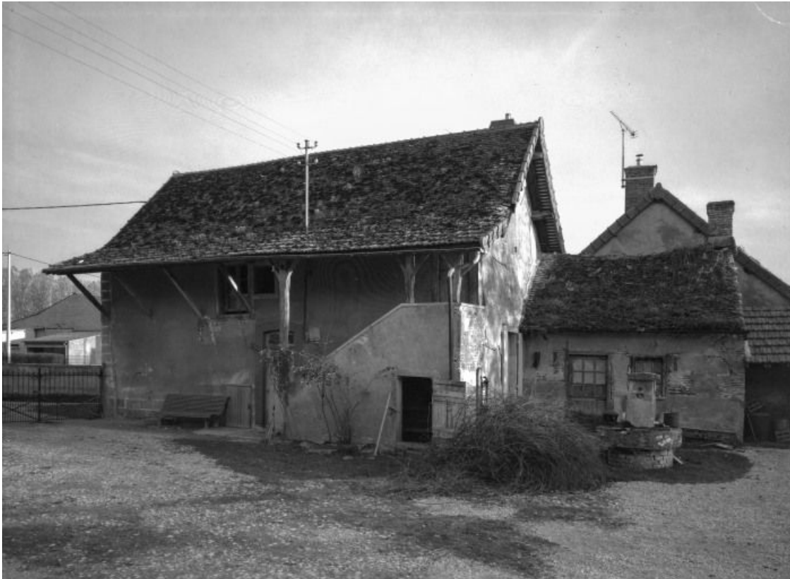
Bâtiment d'habitation et chambre à four.
