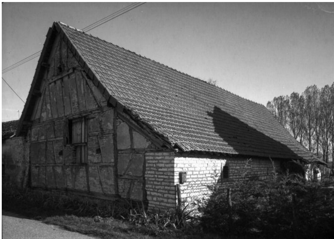
Bâtiment des dépendances, façade sur cour.
