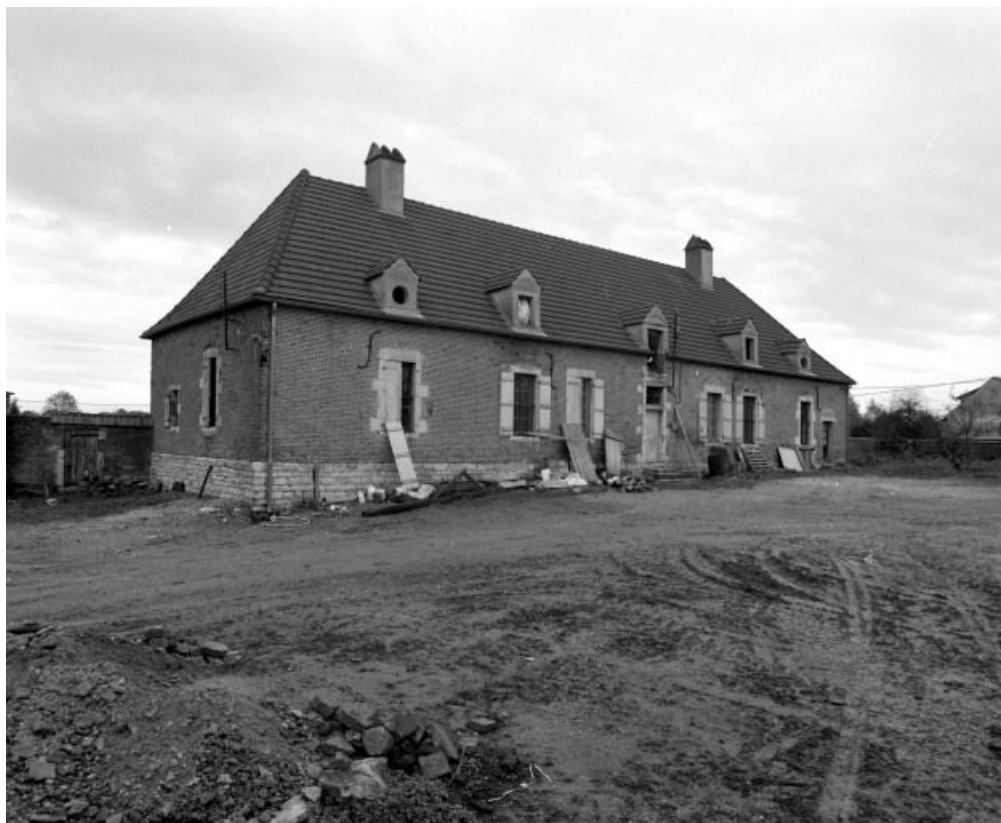
Bâtiment d'habitation, façade sur cour et mur gauche.
