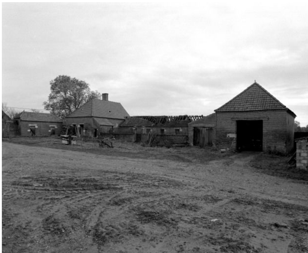
Vue d'ensemble des dépendances nord et est.
