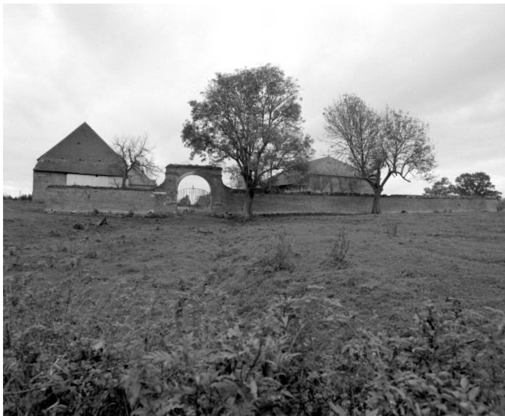
Vue d'ensemble prise du sud, côté du portail postérieur de la cour. 71, Clux, 72 Voie Romaine
