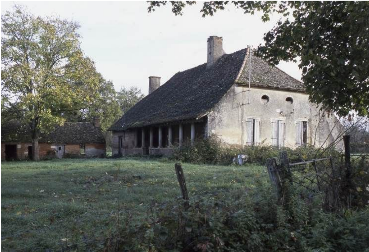
Logis : façade et élévation droite.
