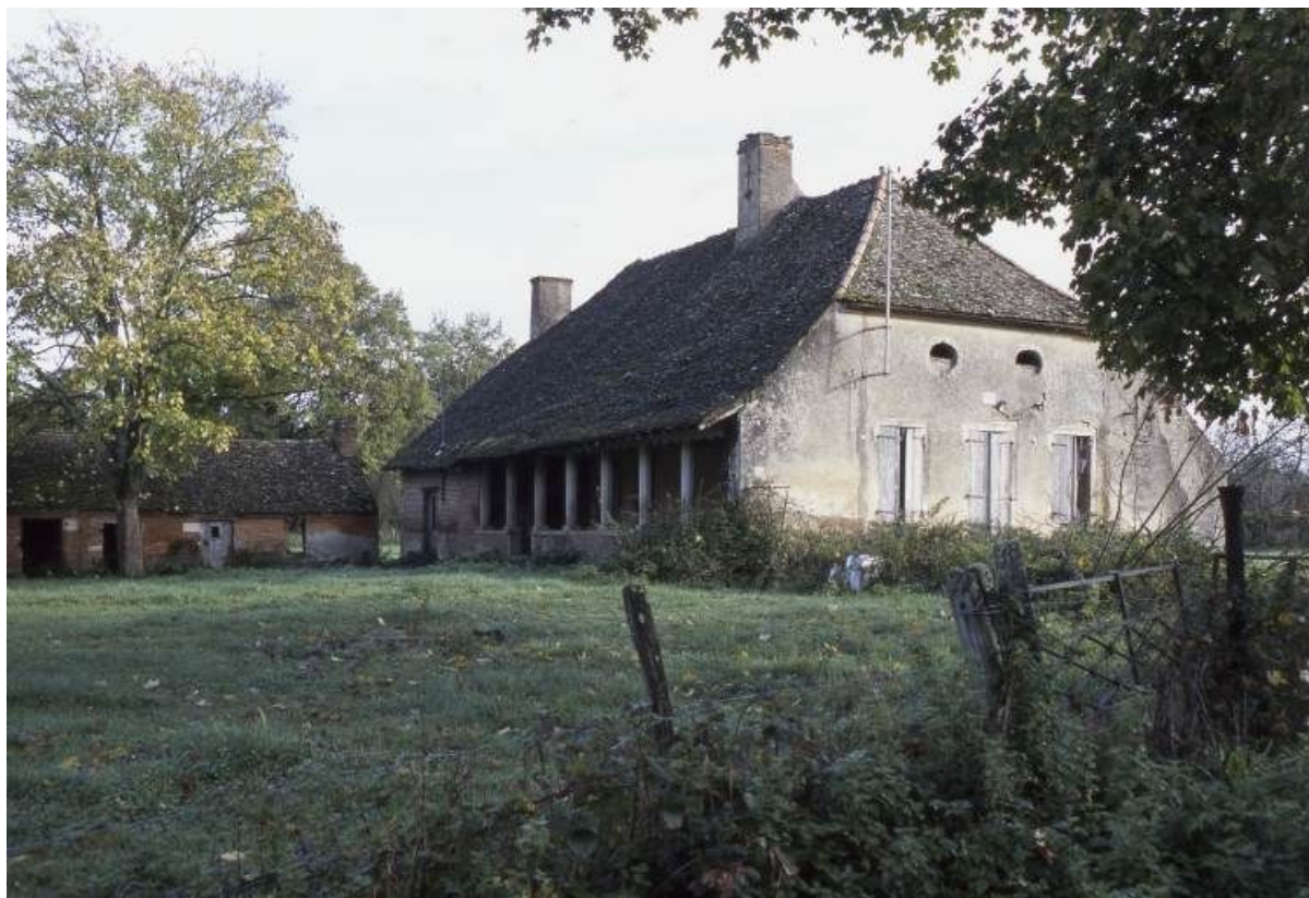
Logis : façade et élévation droite.
