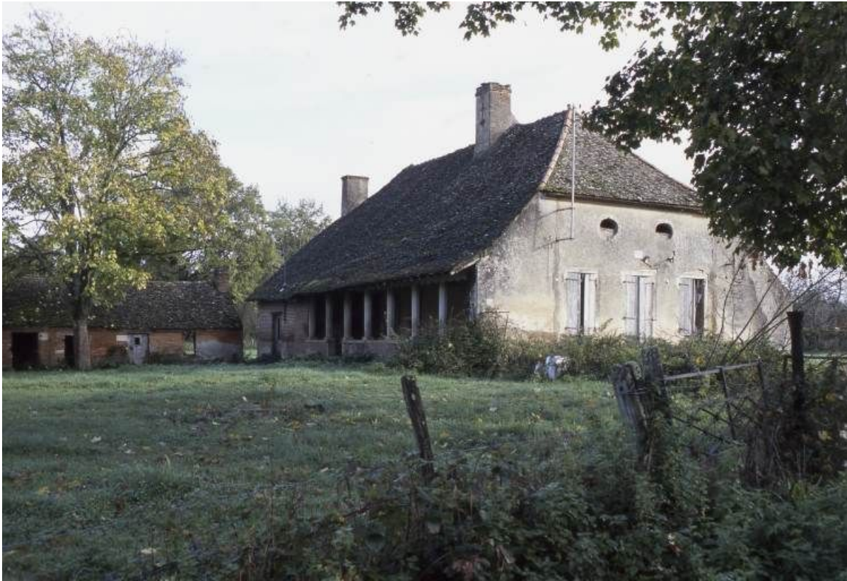
Logis : façade et élévation droite.
