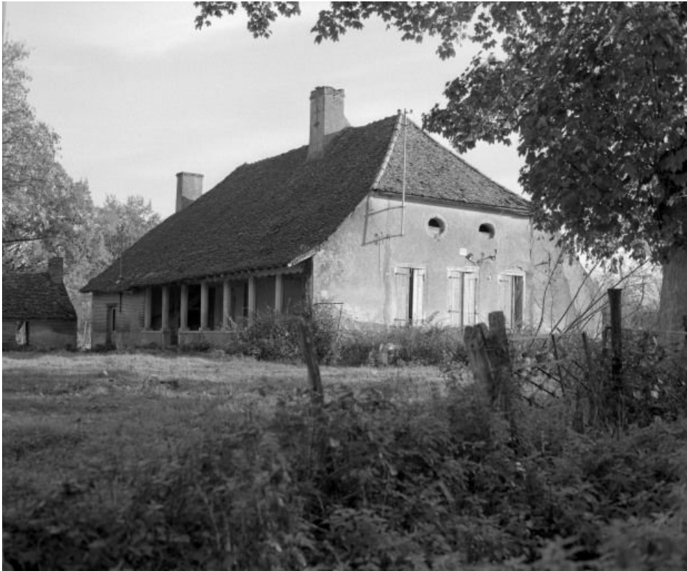
Logis : façade et élévation droite.
