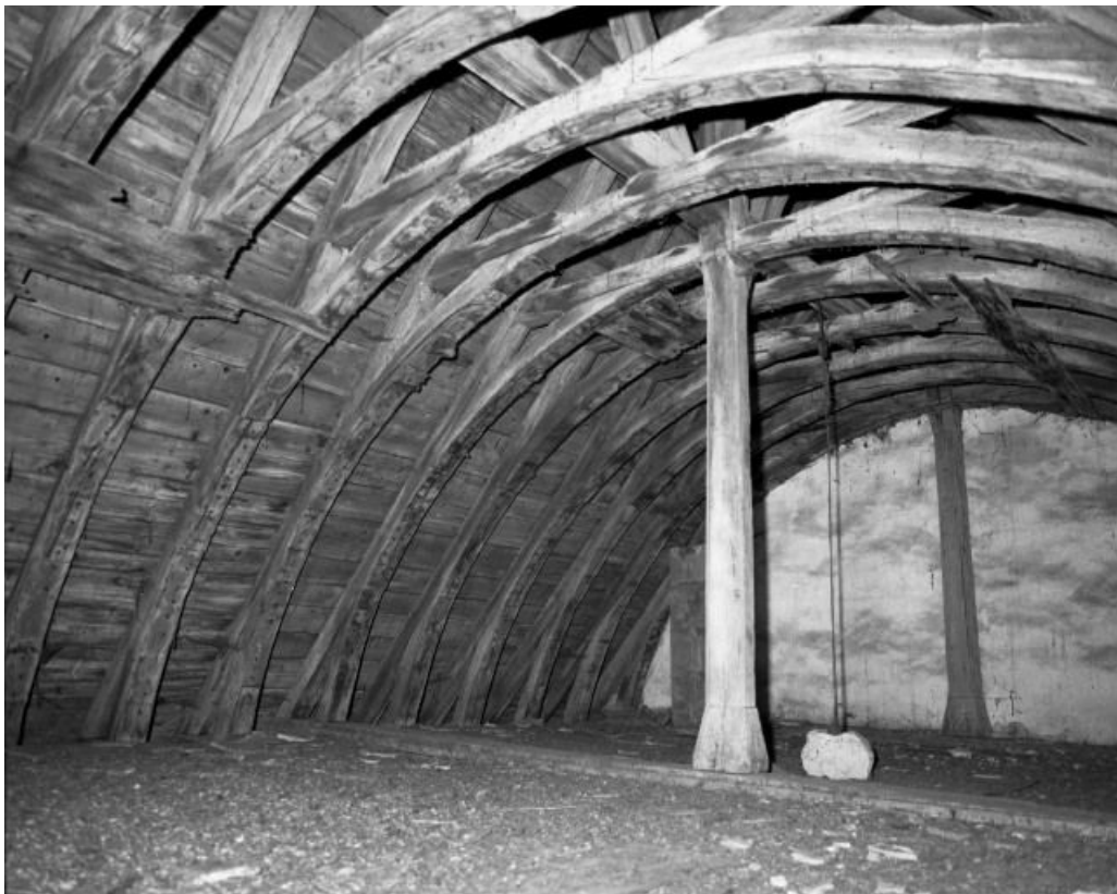
Comble du chœur, partie gauche.
