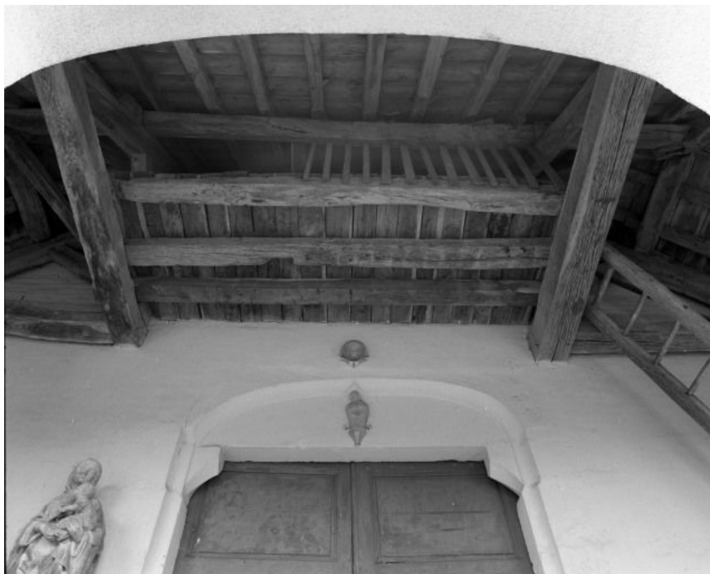
Porche, galerie permettant l'accès au clocher.
