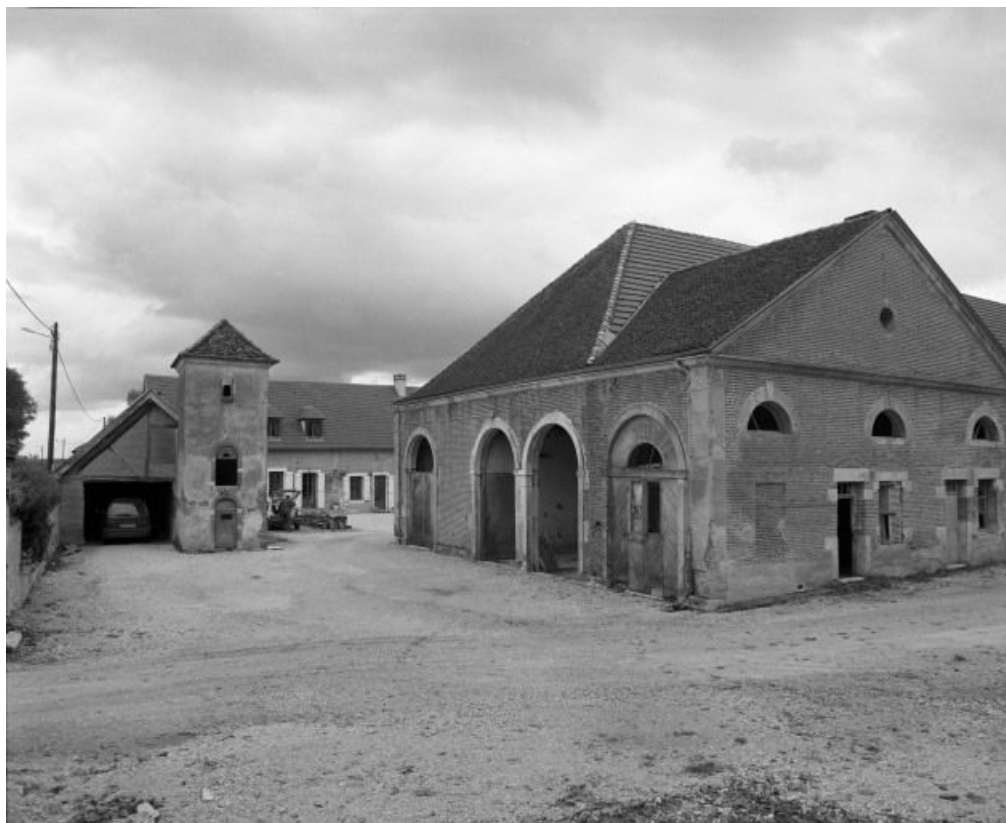
Grand bâtiment de dépendances au 1er plan, logis au fond et petite dépendance avec colombier à gauche. 71, La Villeneuve, 22 Voie Romaine
