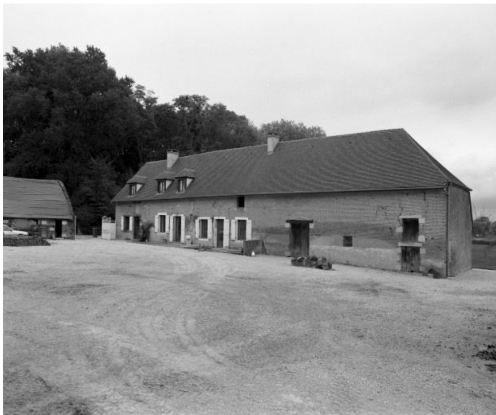
Bâtiment abritant le logis et des dépendances sous le même toit.
