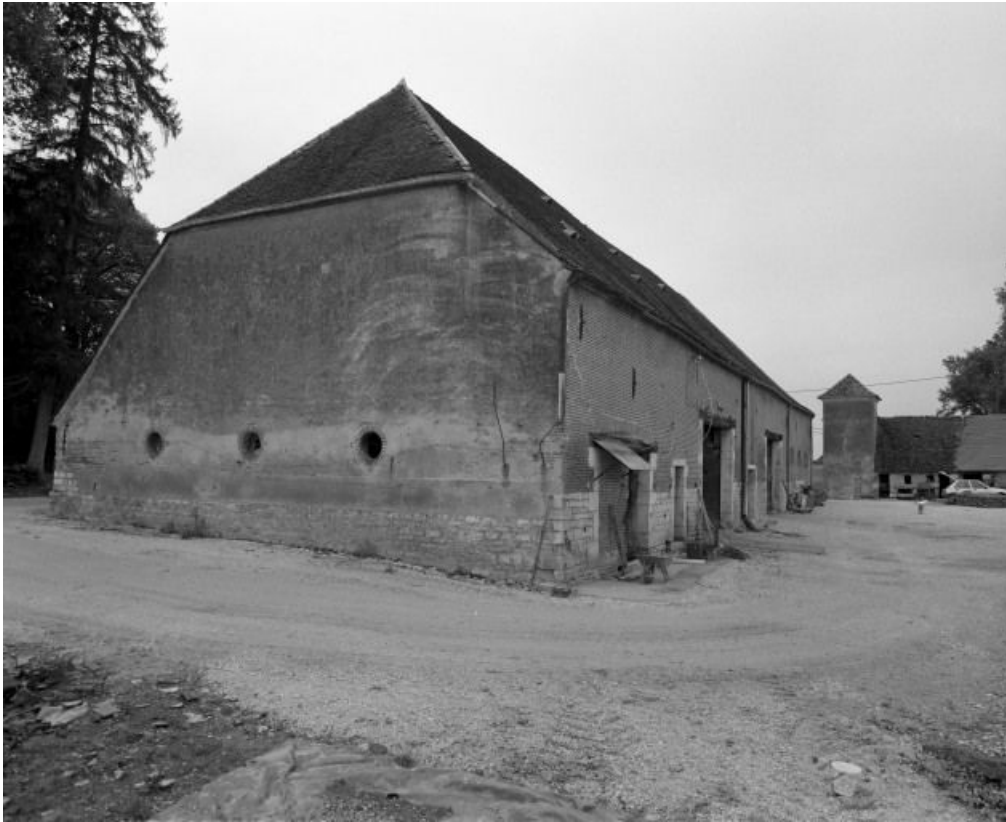
Elévations sud et est du grand bâtiment de dépendances.
