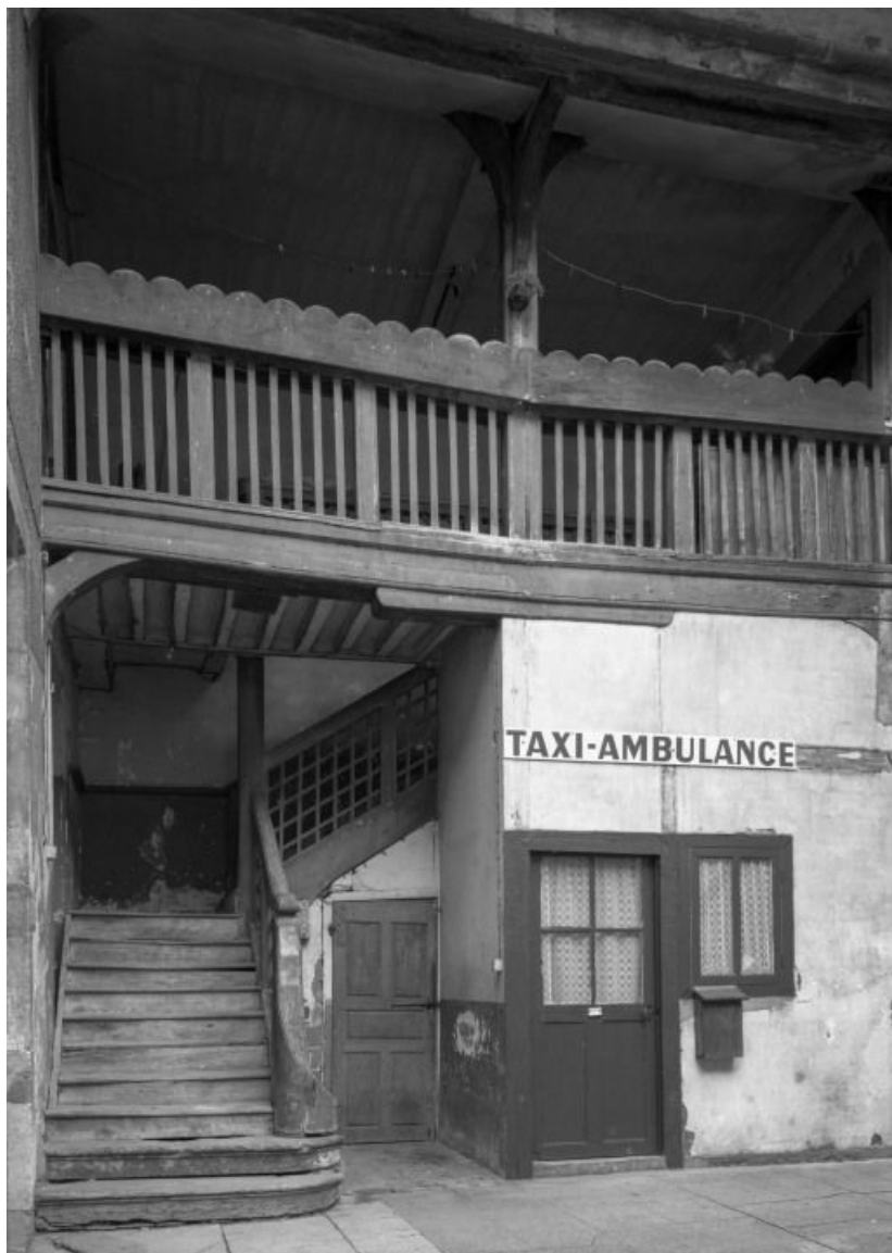
Corps droit de la maison abritant l'escalier et la galerie de l'étage. 71, Verdun-sur-le-Doubs
