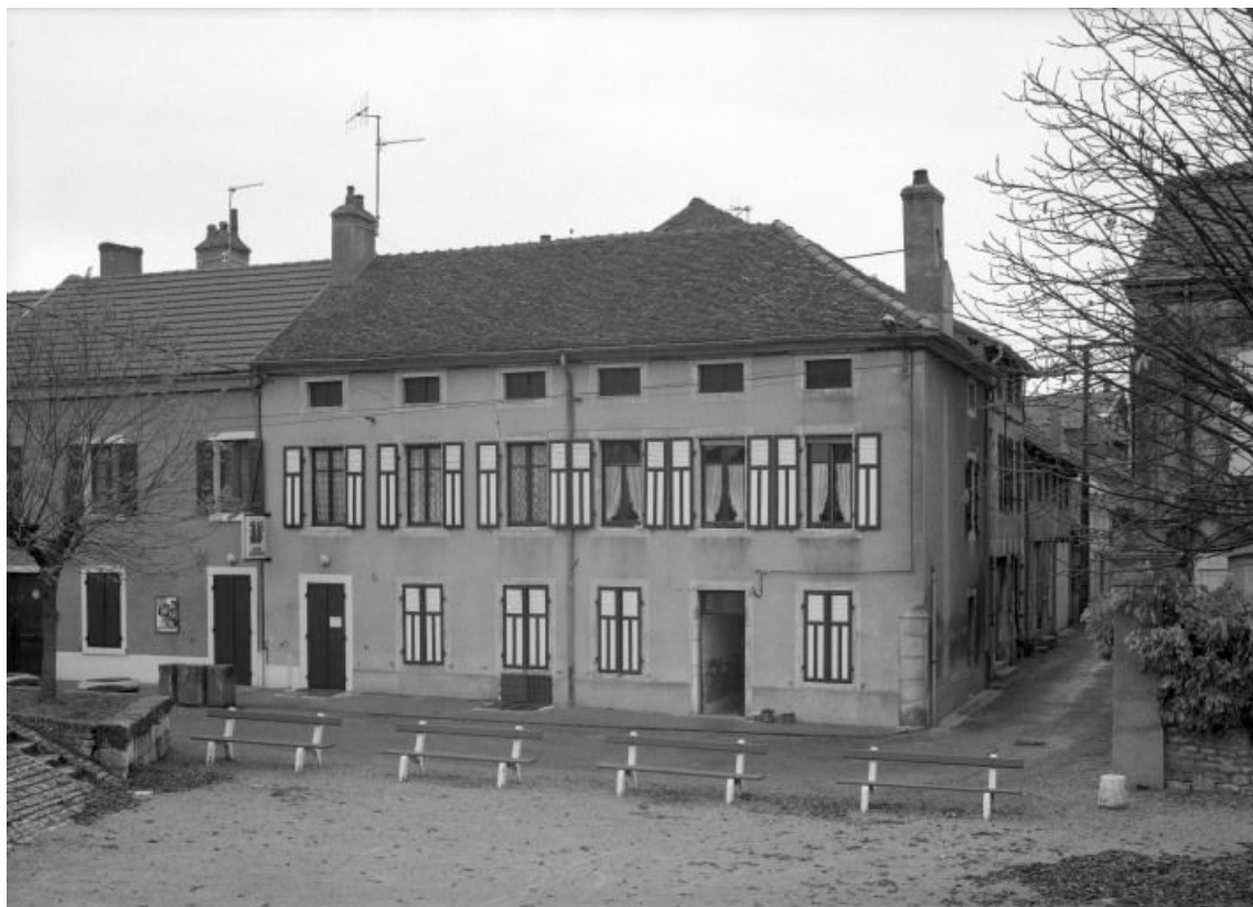
Vue d'ensemble (maison datée 1817). 71, Verdun-sur-le-Doubs
