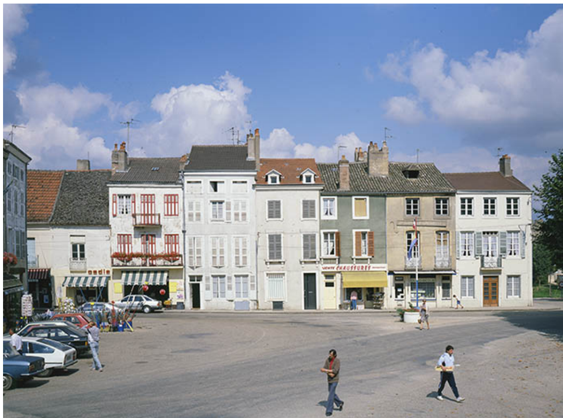
Alignement de 6 maisons, place de la Liberté (cada. 1977, sect. AD, parc. 115 à 121). 71, Verdun-sur-le-Doubs
