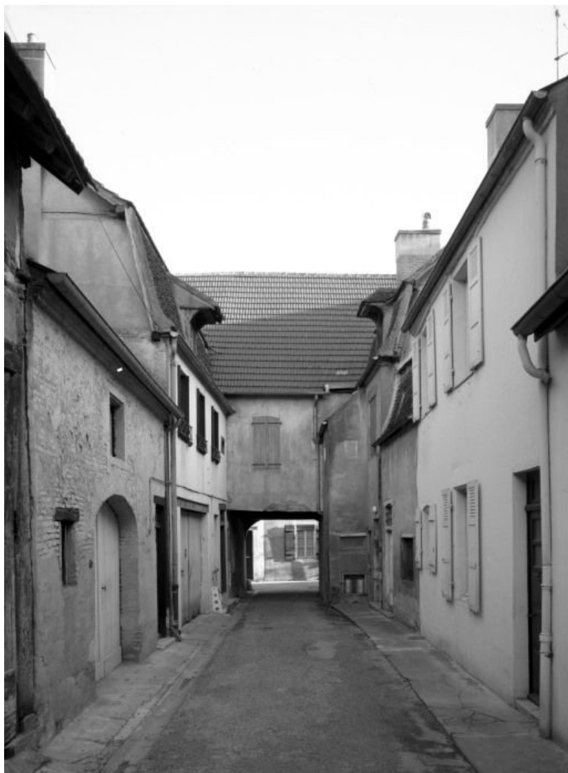
Façade postérieure rue du Portail.
