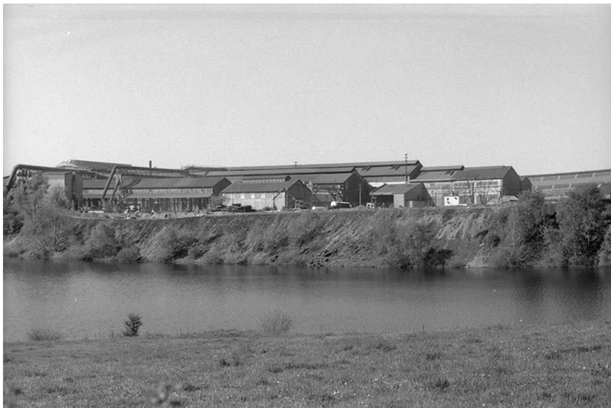
Vue de l'aciérie depuis le nord-est.
