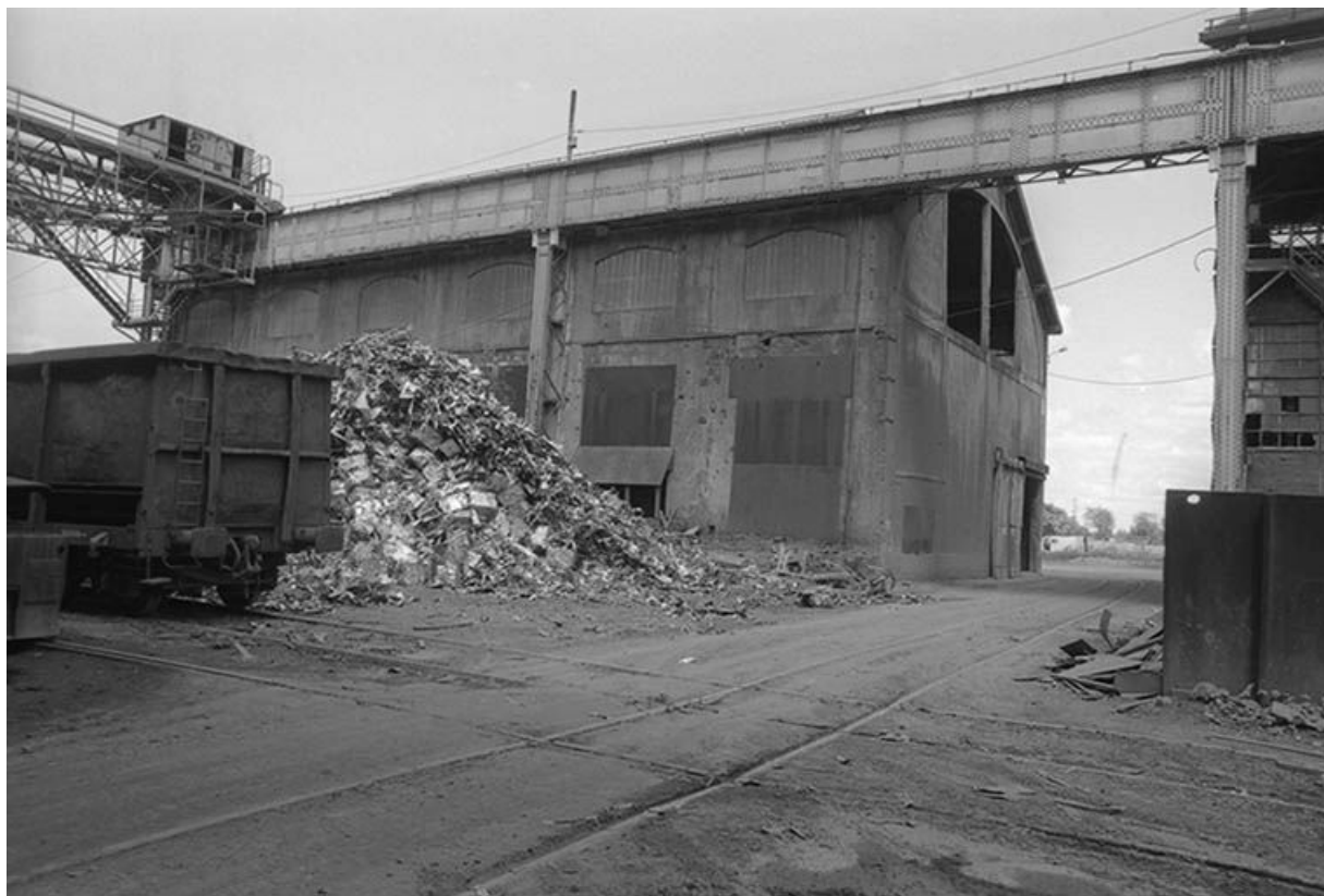
L'ancien atelier dolomitique, vue depuis le parc à riblons.
