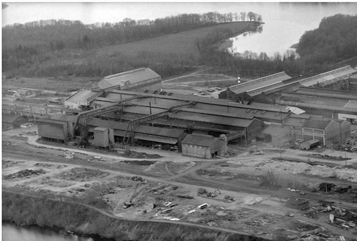
Vue aérienne de l'aciérie depuis le nord-est.
