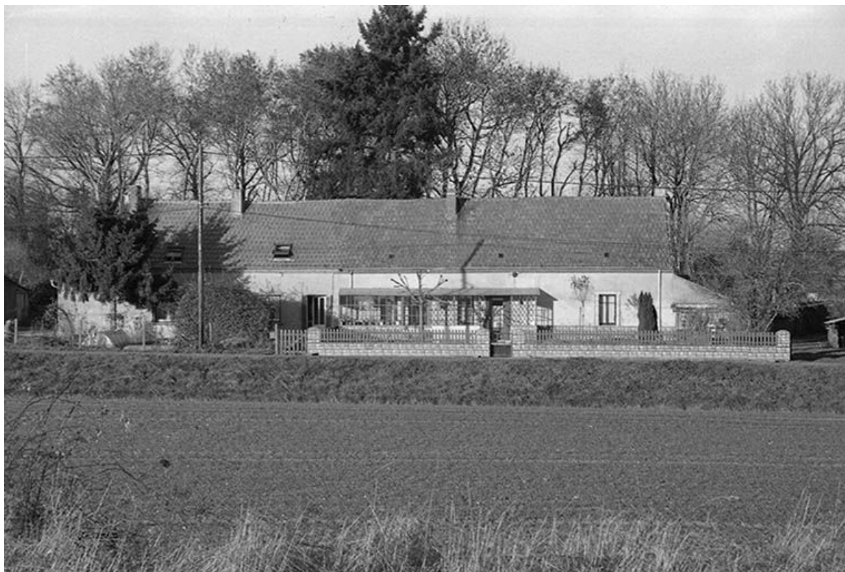
Les logements ouvriers de l'usine de céramique de la Valteuse, vus depuis le sud.
