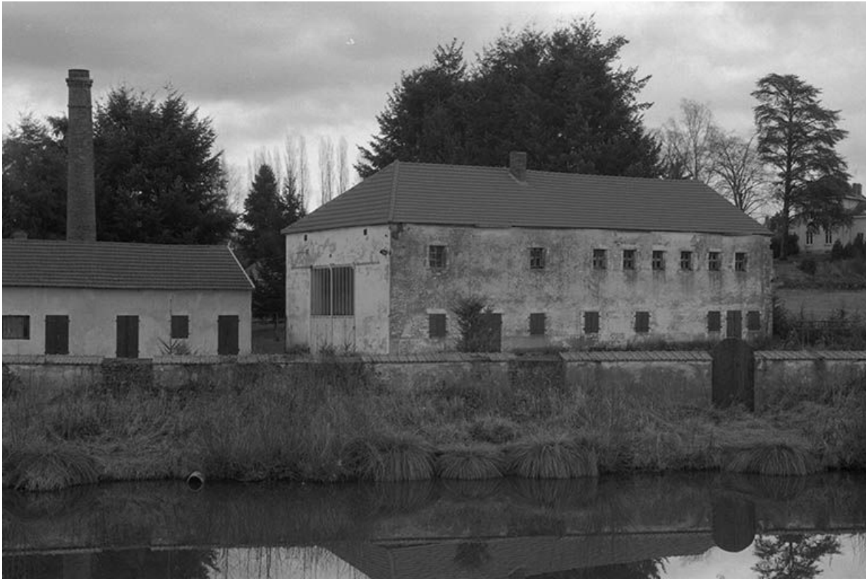
A gauche, remise, garage, dépôt de terre et cheminée ; à droite bâtiment comprenant un four (détruit) et des ateliers de production (tours...) de l'usine "du Bas", vus depuis l'ouest.
