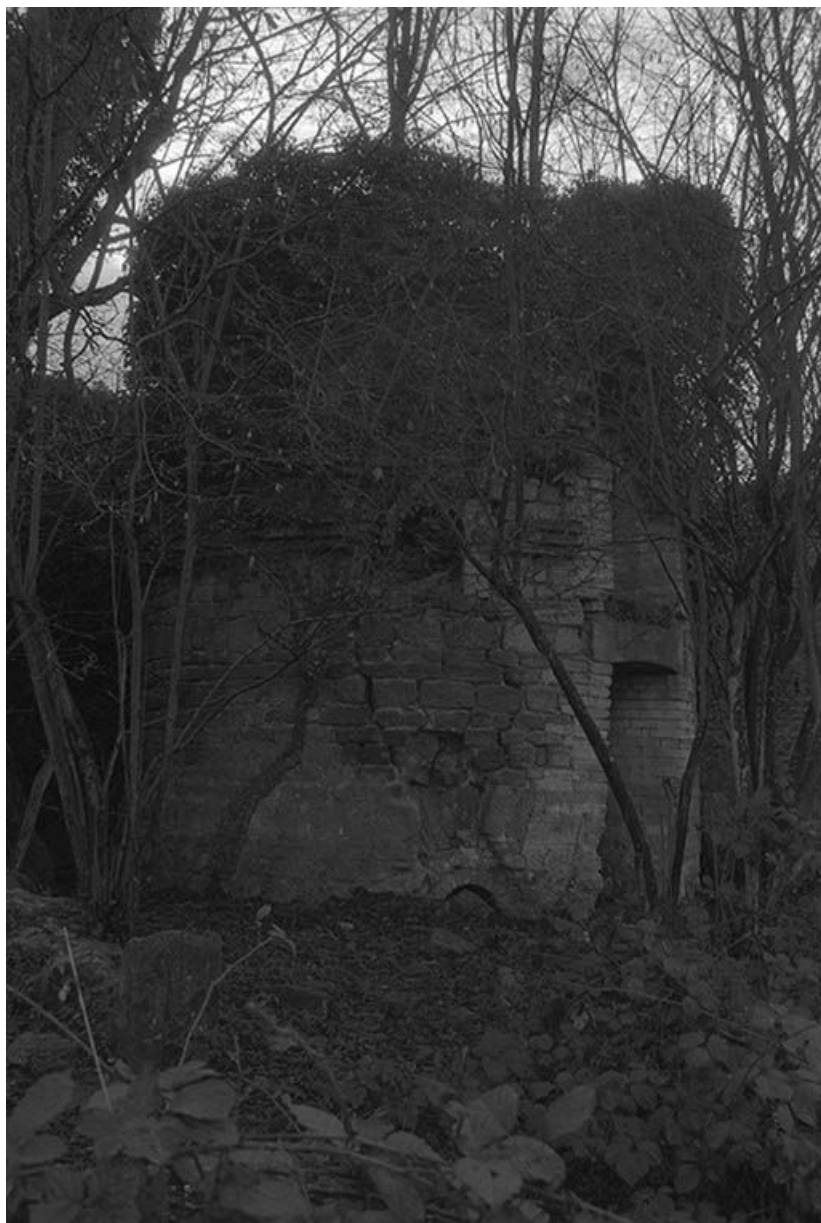
Four ouest de l'usine de céramique du Pont-du-Four.
